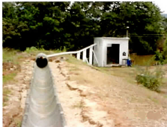
Figura 15: Casa de bombas.
