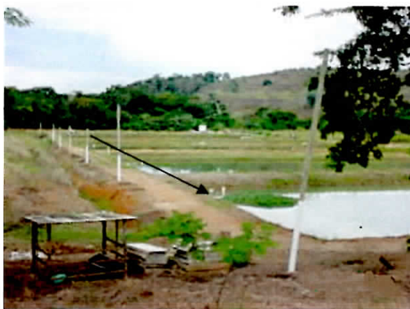
Figura 21: Canal de Drenagem dos tanques.
