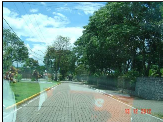
Figura 41 – Rua com sarjetas
