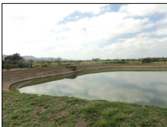
Figura 35 – Lagoa de estabilização – ETE Jardim Real
