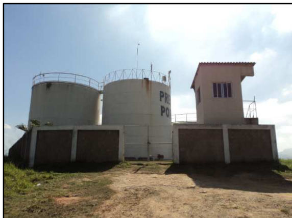
Figura 30 – Reservatório apoiado Jardim das Acácias – vista 1
