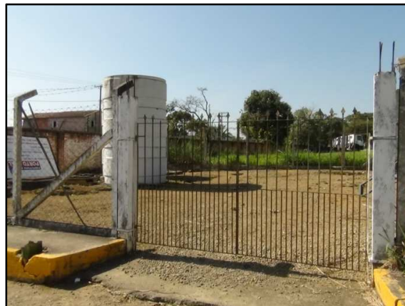
Figura 38 – Sistema de tratamento a nível secundário - Vila Marina
