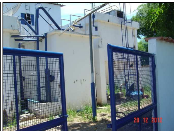
Figura 13 – Acesso a ETA Centro
