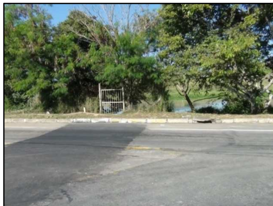
Figura 9 – Acesso a captação da ETA Centro
