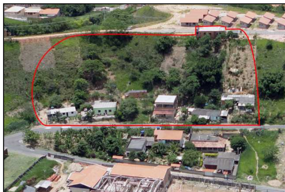
Figura 42 – Área de risco no bairro Jardim das Acácias na Rua 11
