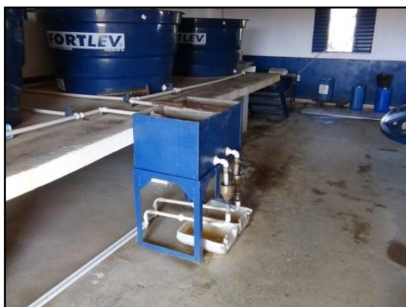
Figura 14 – Casa de química da ETA Centro
