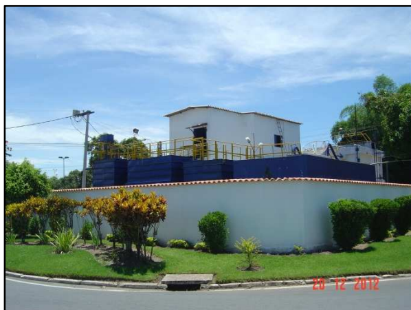
Figura 12 – Vista da ETA Centro
