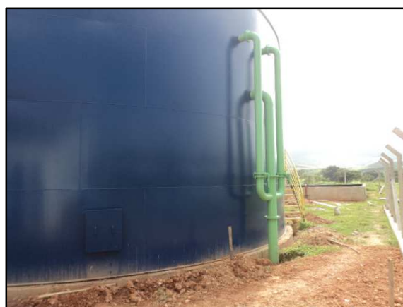
Figura 34 – ETE Centro em construção
