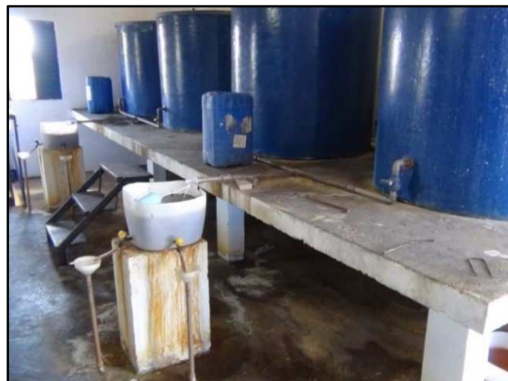
Figura 21 – Casa de química - ETA Freitas Soares
