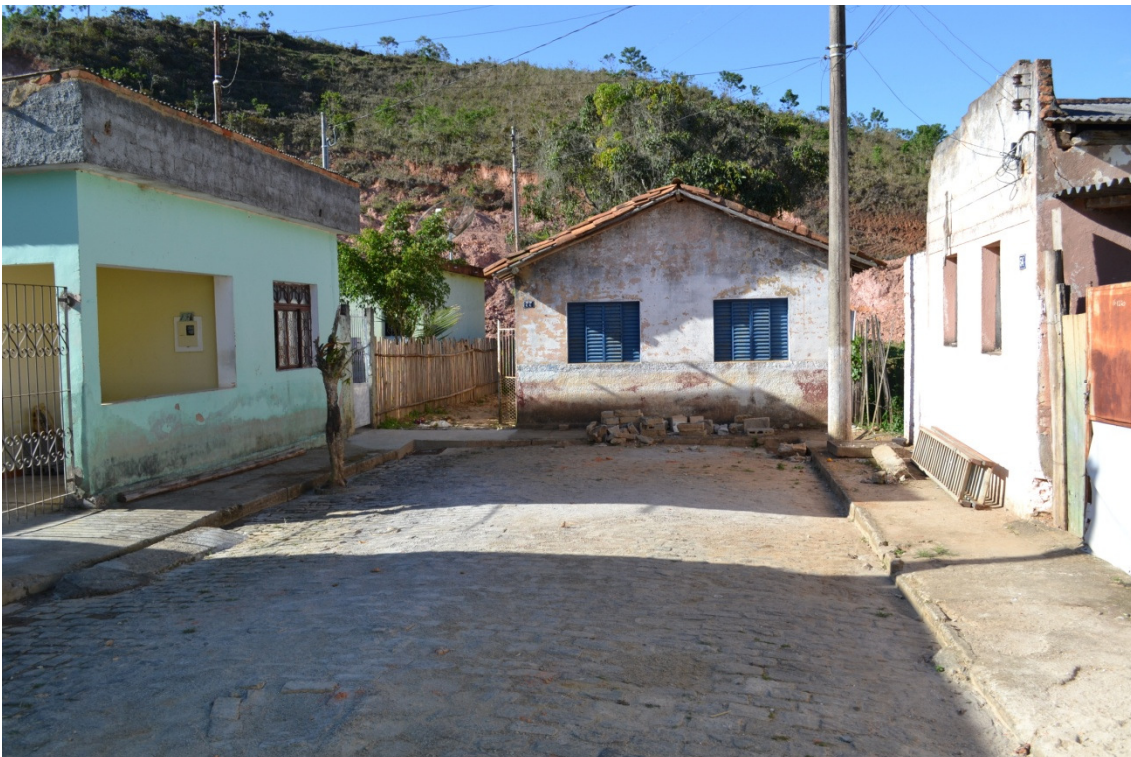
Figura 10: Ponto de alagamento. UTM – 706896/7677828.
