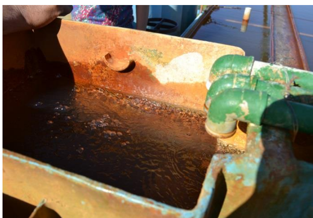
Figura 18: ETA aplicação de cloro Fonte Conen
