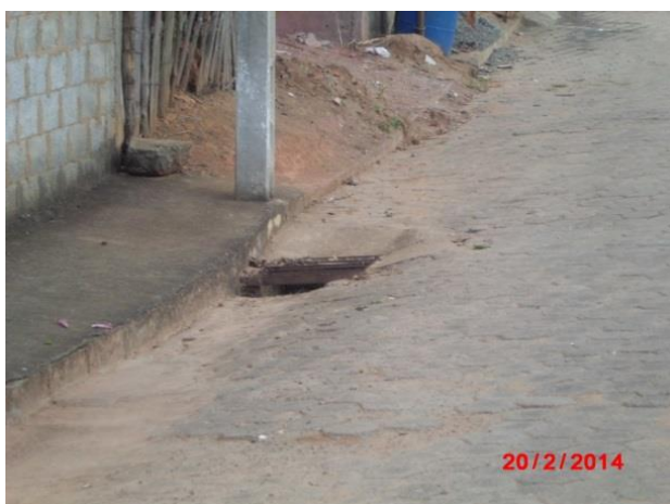
Figura 37: Identificação de estruturas de drenagem Fonte Conen
