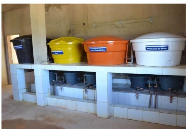
Figura 14: Dosagem de produtos químicos Fonte Conen
