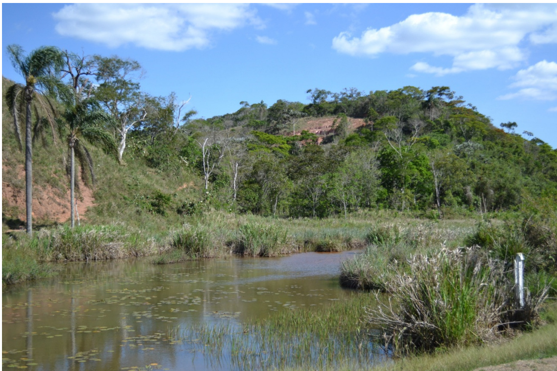
Figura 2: Captação e movimentos de terra. UTM – 707352/7677661.
