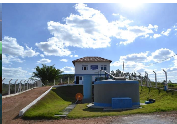
Figura 19: Tanque de contato Fonte Conen
