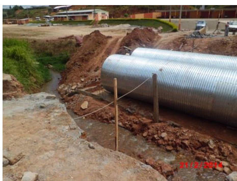
Figura 44: Identificação de estrutura a ser utilizada na retificação de rios Fonte Conen
