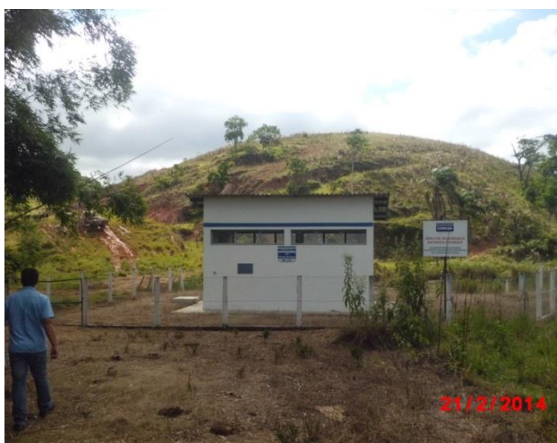
Figura 5: Área da captação e EAB Fonte Conen
