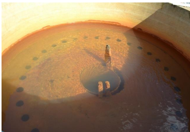
Figura 16: ETA – filtros Fonte Conen
