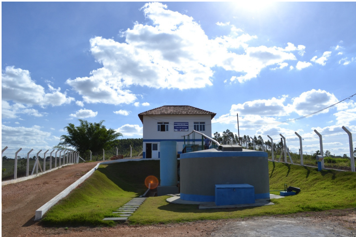
Figura 8: Estação de Tratamento de Água e reservatório de 150.000L - a antiga captação era no rio em frente, o Pinhão. UTM – 707011/7677550.
