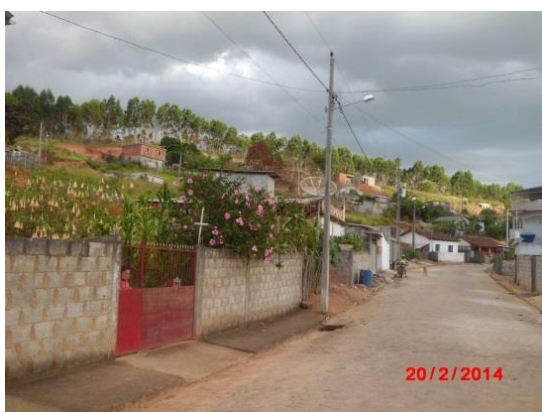
Figura 31: Exemplos de pavimentação no Município de Divinésia Fonte: Conen
