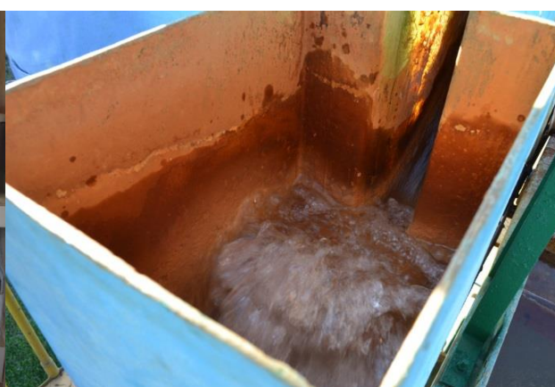
Figura 15: ETA Calha Parshall Fonte Conen
