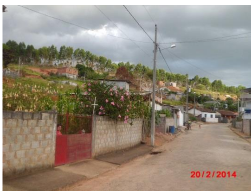
Figura 20: Exemplos de pavimentação no Município de Divinésia. Fonte: Conen
