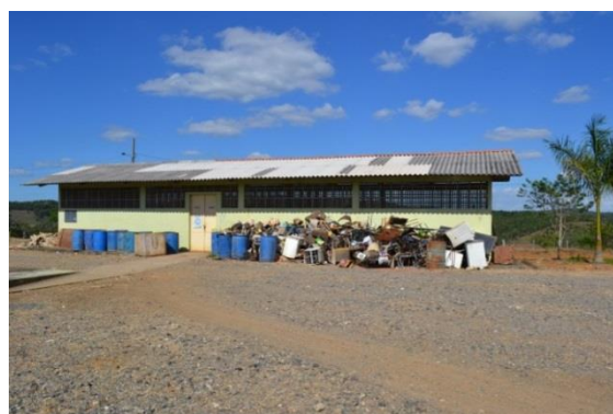
Figura 42: Galpão para armazenamento de recicláveis Fonte: Conen
