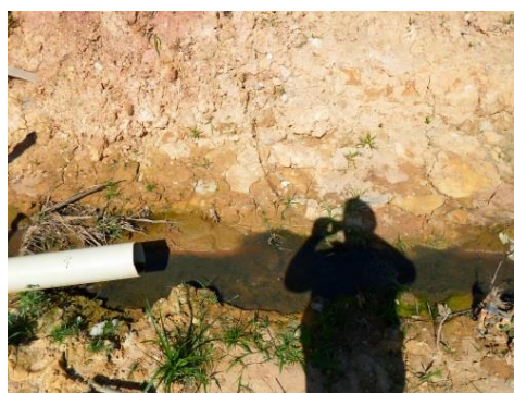
Figura 39: Lançamento de esgoto in natura em córrego Fonte: Conen
