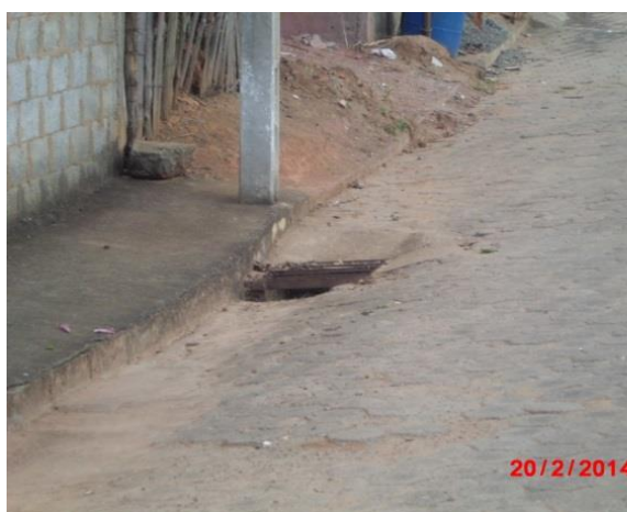
Figura 35: Identificação de estruturas de drenagem Fonte: Conen
