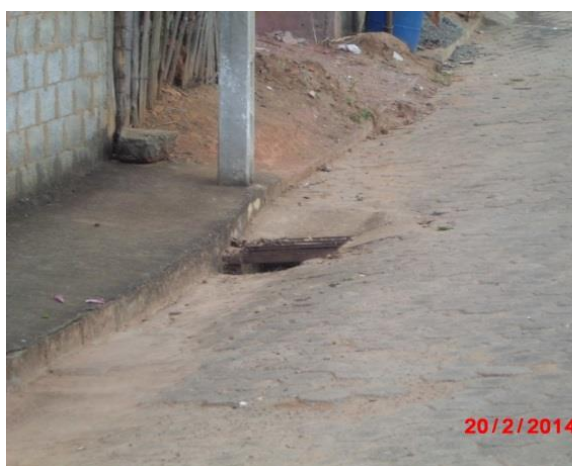
Figura 35: Identificação de estruturas de drenagem Fonte: Conen
