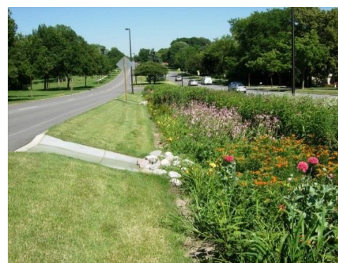
Figura 47: Grades verdes implantadas. Fonte: Bioretention/bioswale in median of Grange Avenue em Greendale, Winsconsin
