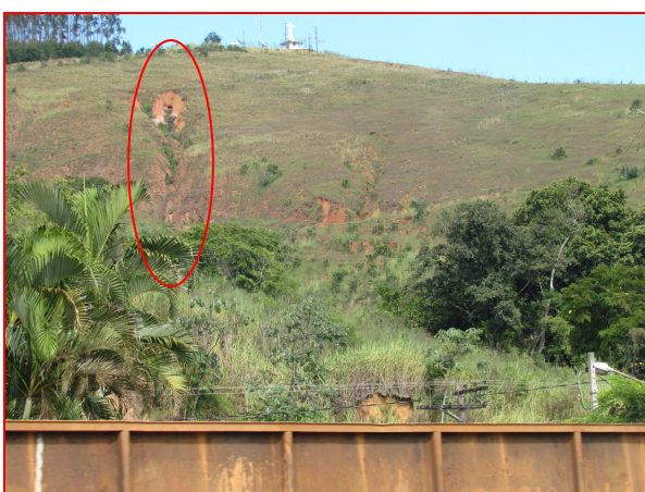
Foto 29: Destaque de voçoroca devido ao desmatamento, podendo ocasionar deslizamento de terra no período de chuvas. Queluz – SP.
