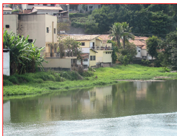
Foto 30: Construção irregular a margem do rio na cidade de Queluz – SP e vegetação característica de lançamento de esgoto.
