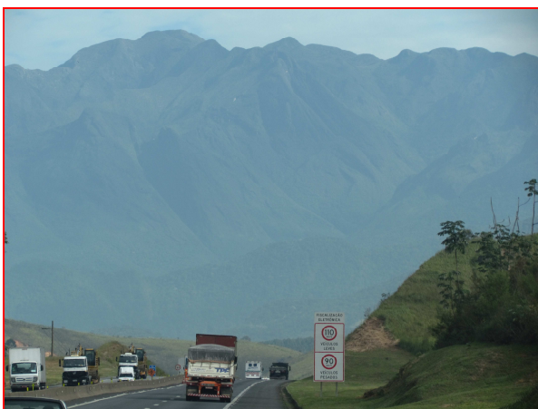
Foto 1: Rodovia Presidente Dutra (BR-116), sentido Rio-São Paulo. Caracterizando a serra desmatada ao fundo.
