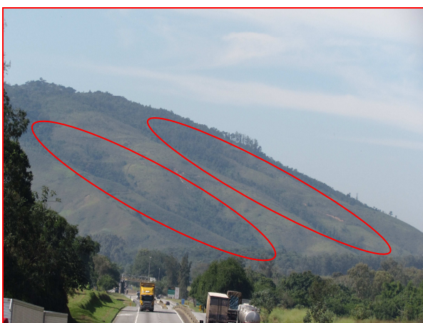
Foto 33: Desmatamento em morro e voçoroca ocasionada pela chuva (detalhe).
