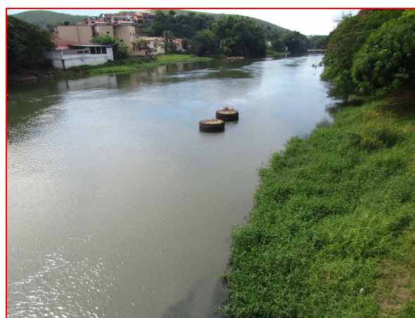
Foto 24: Detalhe de alta turbidez da água e construção irregular a margem do rio, possibilitando o lançamento de esgoto não tratado na cidade de Queluz- SP.
