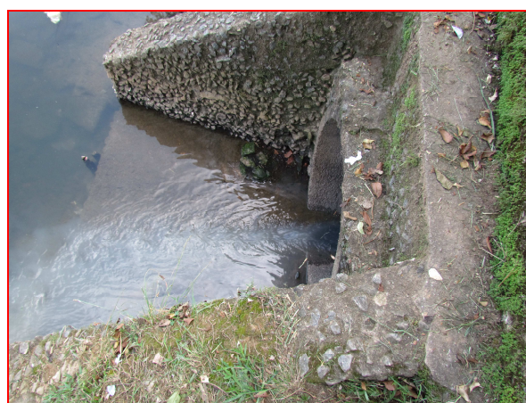
Fotos 35 e 36: Lançamento de esgoto no curso do rio com características de não ter recebido o tratamento, devido a sua coloração esbranquiçada. Situada no centro da cidade de Resende – RJ.
