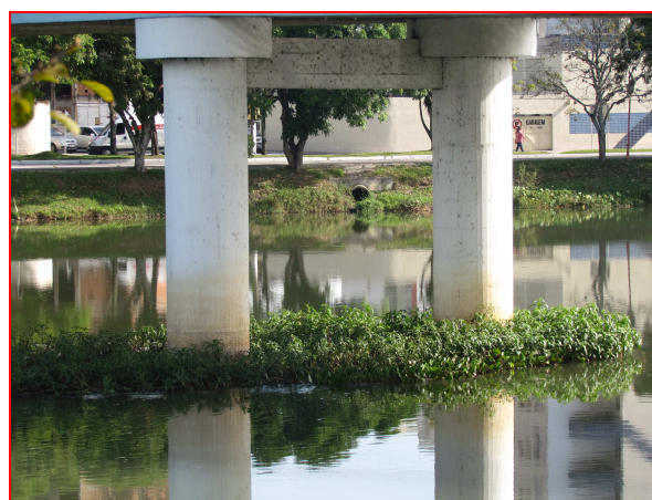
Foto 34: Depósito de vegetação em pilar de ponte na cidade de Resende – RJ. Não é recomendado este tipo de pilar em construção de pontes.
