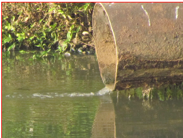
Fotos 49 e 50: Destaque de lançamento de esgoto em rio com aparecimento de ilha de assoreamento, caracterizando a emissão de esgoto sem o devido tratamento. Situado as margens da CSN em Volta Redonda – RJ.
