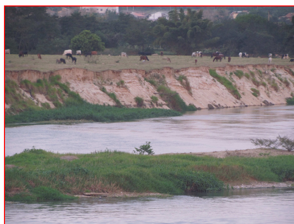
Foto 12: Detalhe de ilha de assoreamento, erosão em margem e desmatamento de mata ciliar para utilização de pastos – Caçapava, SP.
