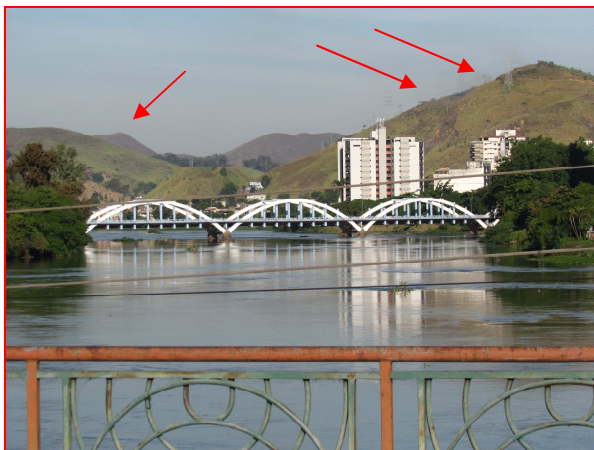
Foto 43: Em detalhe, perfil dos morros desmatados e erodidos a margem do rio na cidade de Barra Mansa – RJ.
