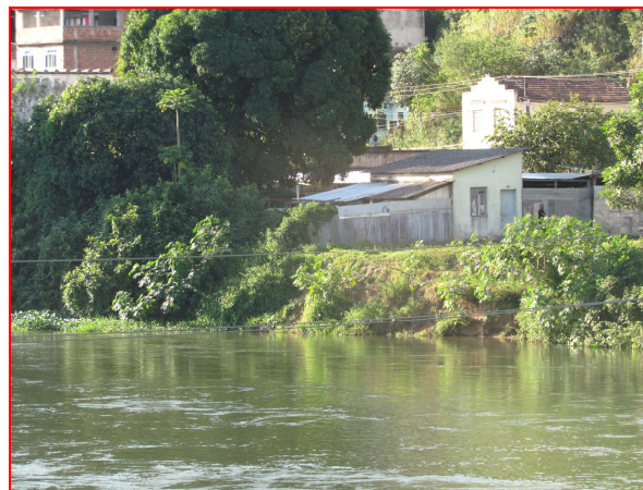
Foto 44: Construção irregular a margem e desmatamento de mata ciliar, e possível lançamento de esgoto devido à vegetação
