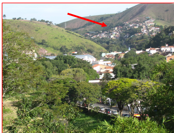
Foto 4: Desmatamento em mata ciliar ao Paraíba do Sul e construções sobre encosta desprotegida (deslizamento), cidade de Paraibuna - SP.
