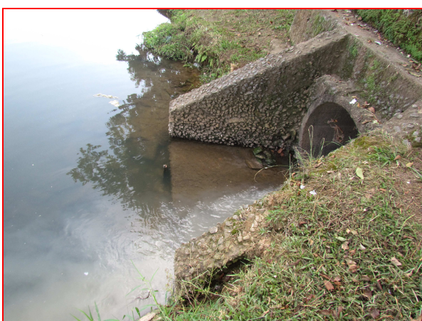
Fotos 35 e 36: Lançamento de esgoto no curso do rio com características de não ter recebido o tratamento, devido a sua coloração esbranquiçada. Situada no centro da cidade de Resende – RJ.
