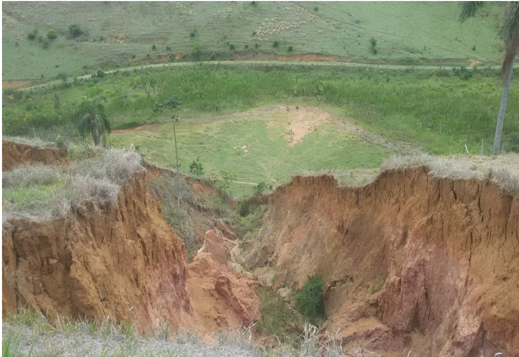
Figura 69. Voçoroca próximo a APP do Rio Piraí - Fazenda Fortaleza
