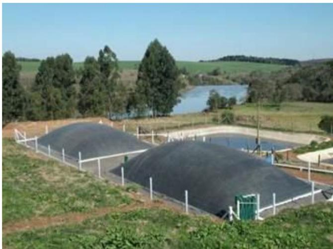
**Figura 3.** Biodigestor modelo Canadense.
