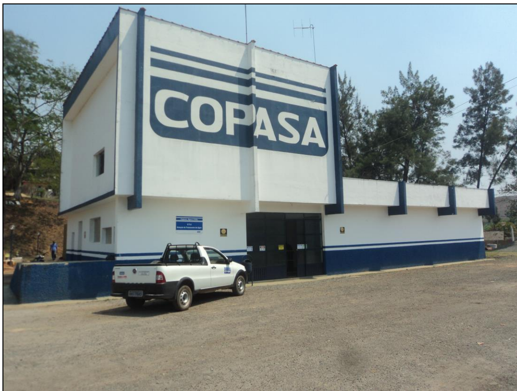
Figura 31 – Entrada da estação de tratamento de água – Distrito Sede
