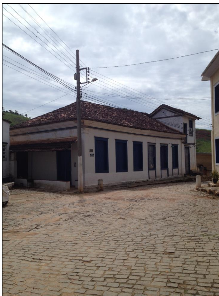
Figura 62 – Pavimentação com paralelepípedo – Distrito de Angustura. Fonte: DRZ – Gestão Ambiental
