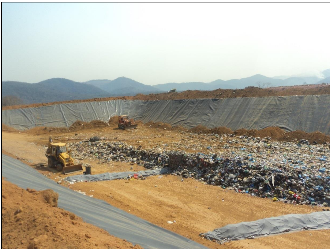
Figura 76 – Célula de deposição de resíduos do aterro sanitário da empresa Compromisso Ambiental
