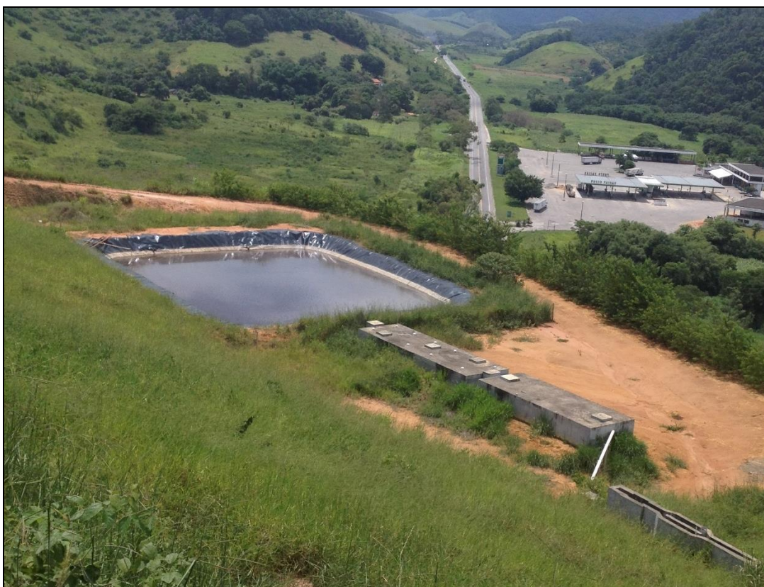
Figura 77 - Lagoa de tratamento do aterro sanitário da empresa Compromisso Ambiental
