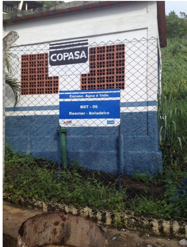
Figura 26 – Booster 8 – Distrito Sede Fonte: DRZ - Gestão Ambiental
