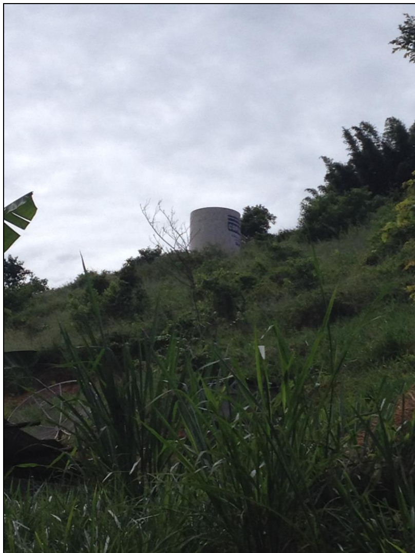
Figura 54 - Reservatório apoiado - Distrito Angustura Fonte: DRZ-Gestão Ambiental.
