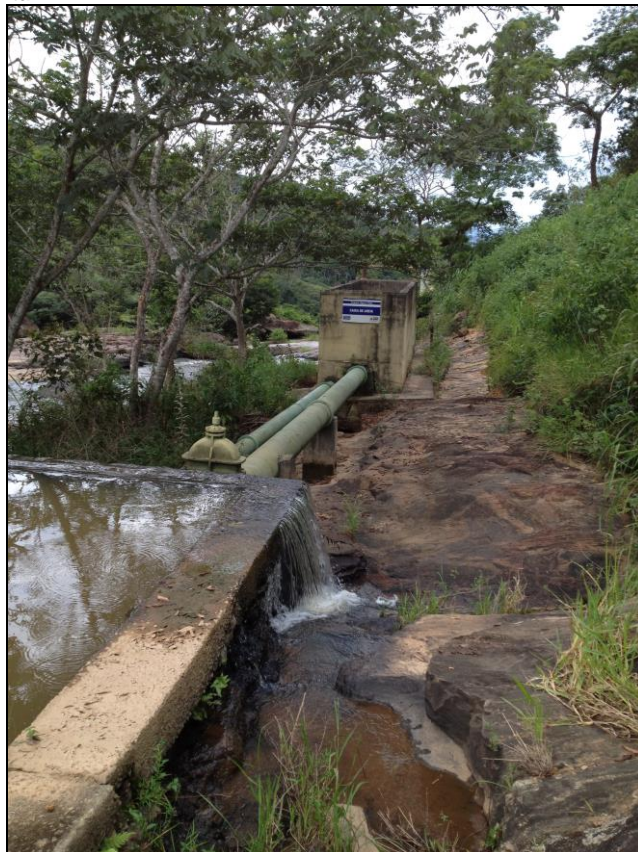
Figura 10 – Caixa de areia da captação de água bruta no Rio do Aventureiro – Distrito Sede. Fonte: DRZ - Gestão Ambiental
