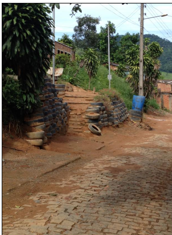
Figura 67 – Ponto de deslizamento controlado com barreira de pneus.
