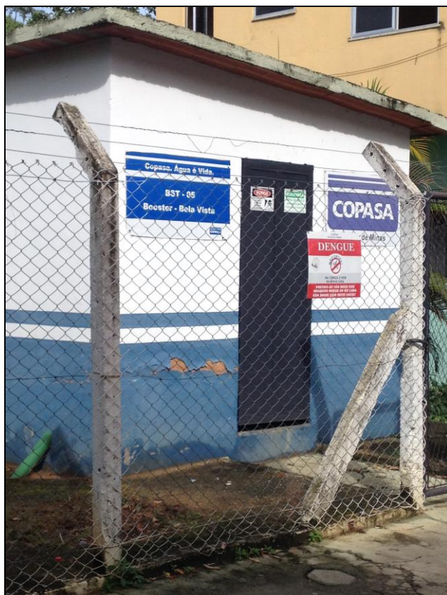
Figura 23 – Booster 5 – Distrito Sede Fonte: DRZ - Gestão Ambiental
