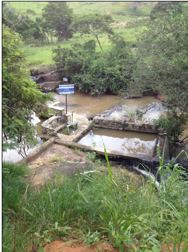
Figura 9 - Captação de água bruta no Rio do Aventureiro – Distrito Sede. Fonte: DRZ - Gestão Ambiental
