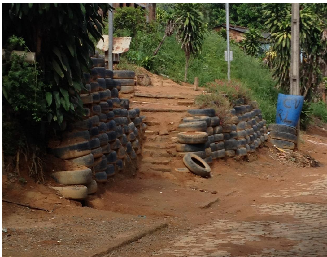
Figura 74 – Contenção de encostas com pneu no Distrito de Angustura
