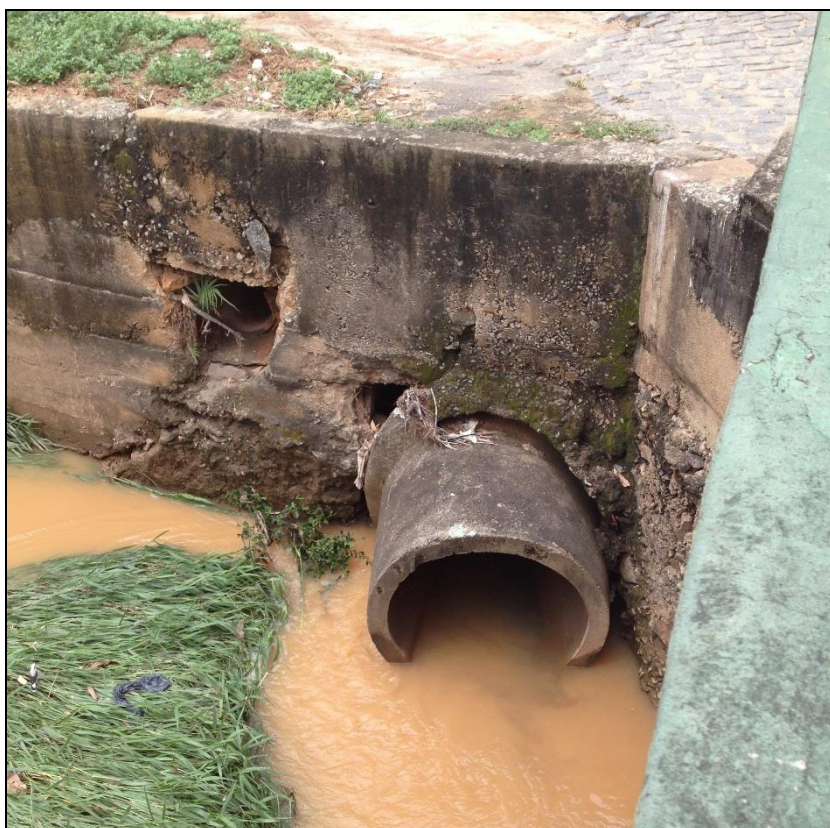
Figura 65 - Rede de microdrenagem com lançamento de efluente de esgoto doméstico Fonte: DRZ – Gestão Ambiental
