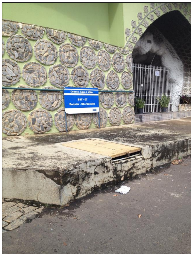
Figura 25 – Booster 7 – Distrito Sede Fonte: DRZ - Gestão Ambiental
