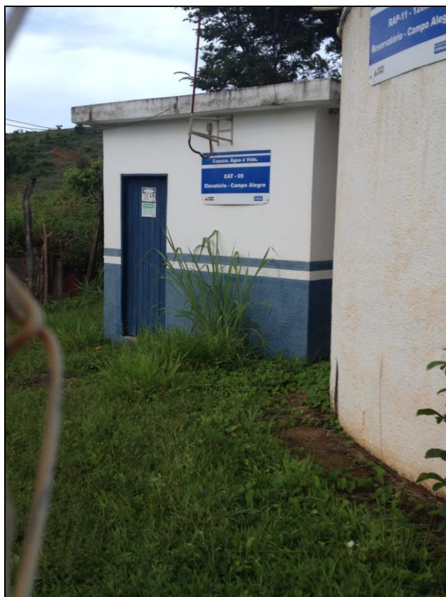
Figura 18 - Estação elevatória 5 – Distrito Sede
