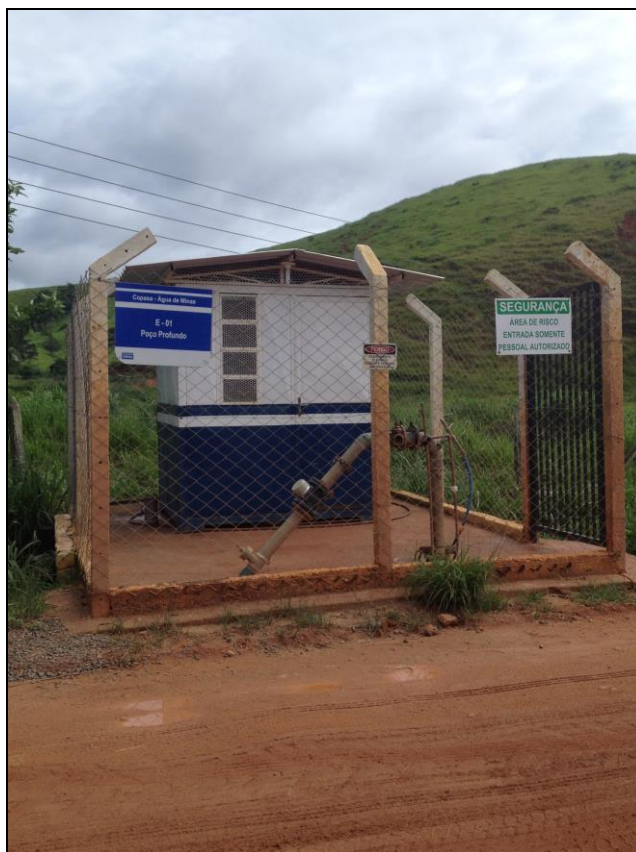
Figura 51 – Poço 01 – Distrito Angustura Fonte: DRZ – Gestão Ambiental
