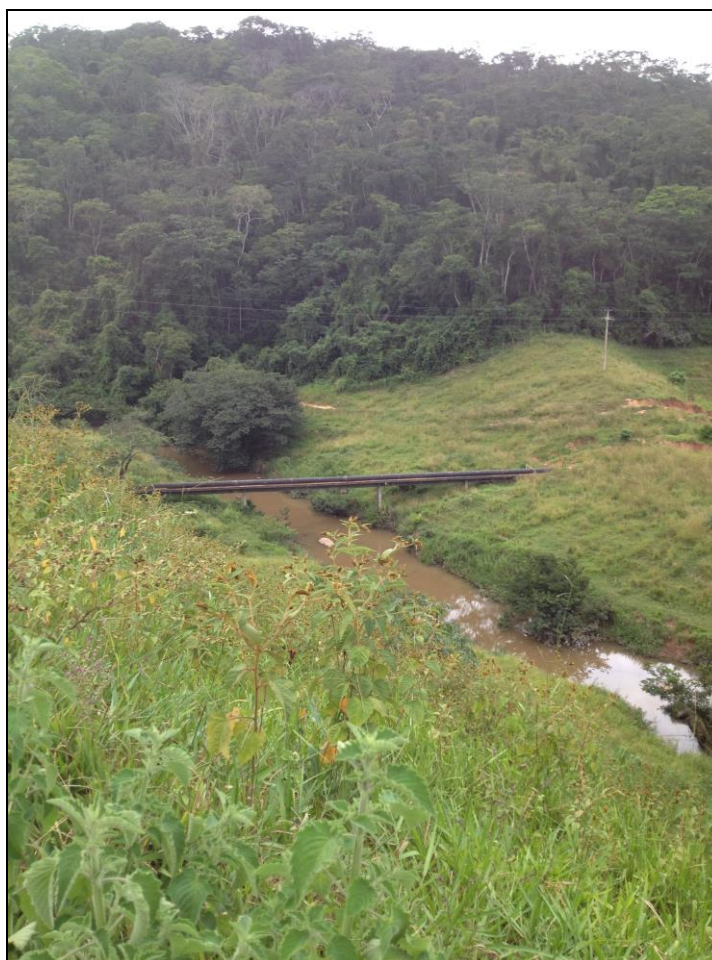
Figura 28 – Adutora de água bruta (AAB) – Distrito Sede
