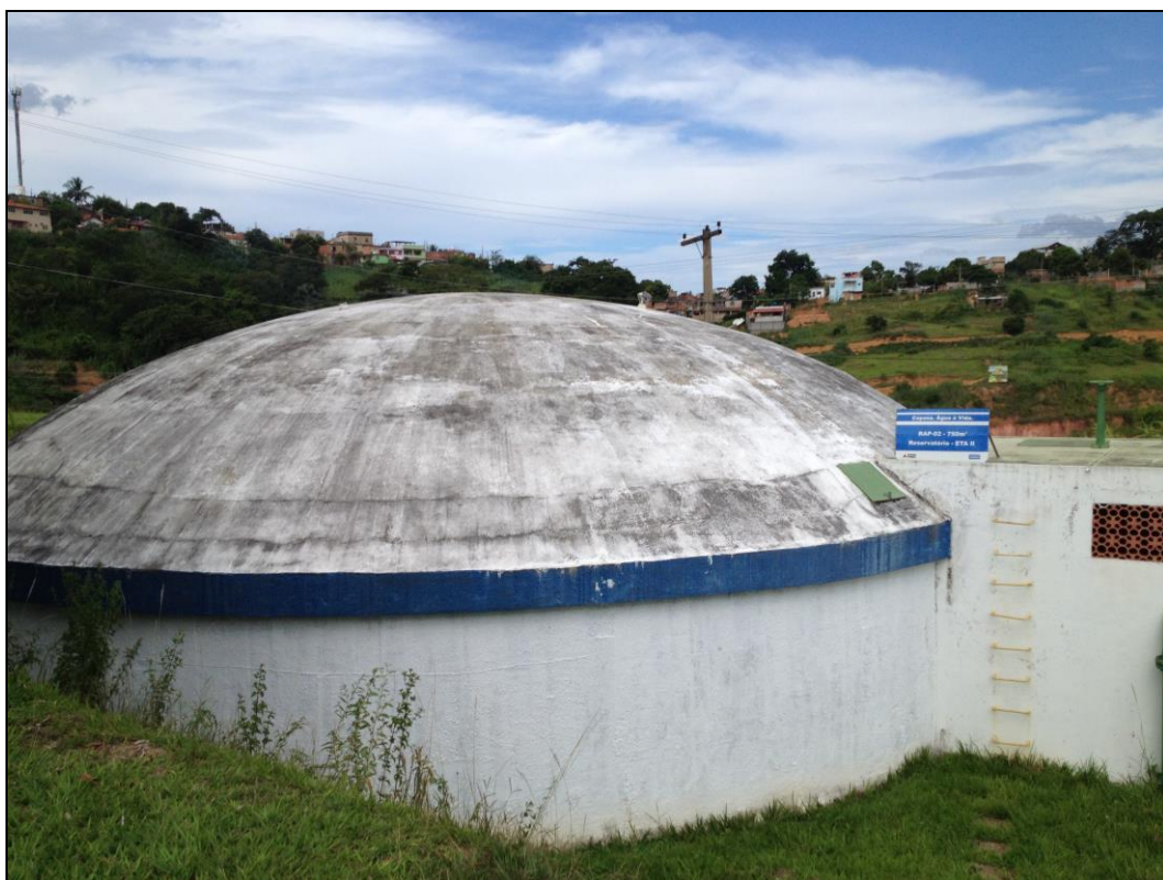
Figura 41 – R2 – Distrito Sede Fonte: DRZ - Gestão Ambiental
