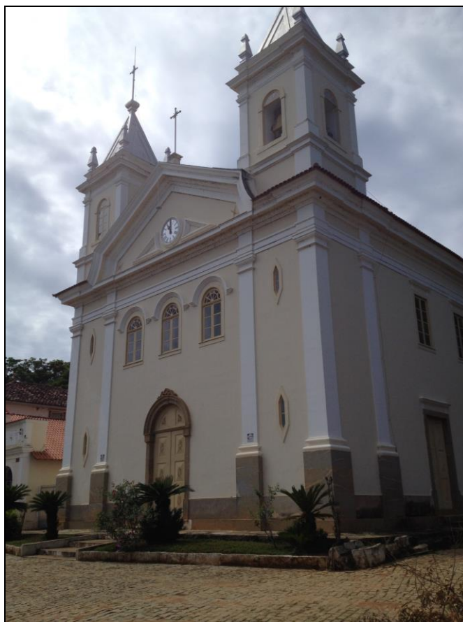
Figura 63 – Pavimentação com paralelepípedo – Distrito de Angustura. Fonte: DRZ – Gestão Ambiental
