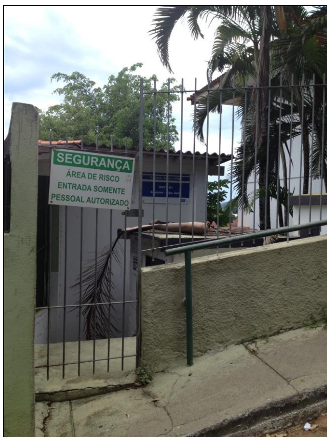
Figura 19 – Booster 1 – Distrito Sede
