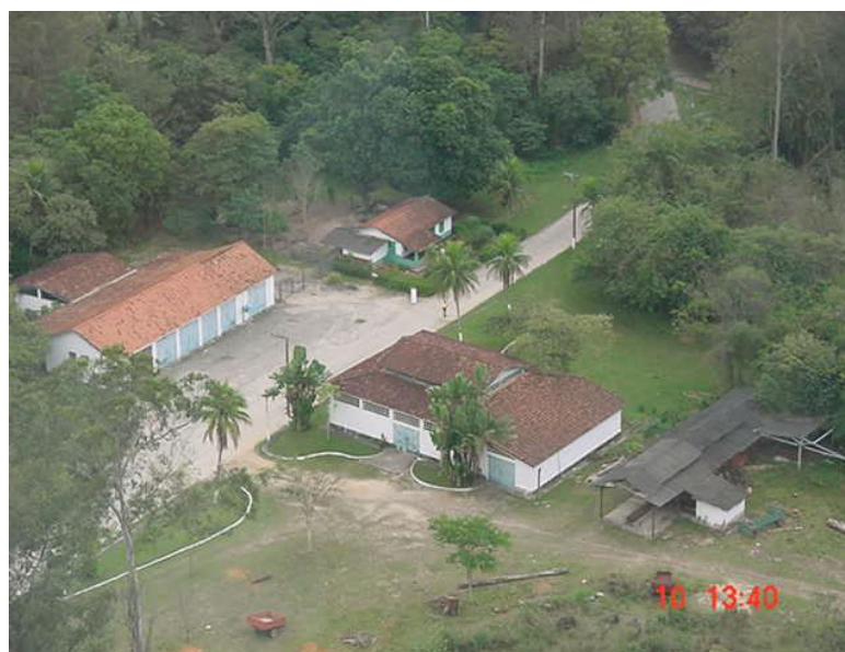
Figura 5 - Oficina de carpintaria – galpão garagem – oficina mecânica
