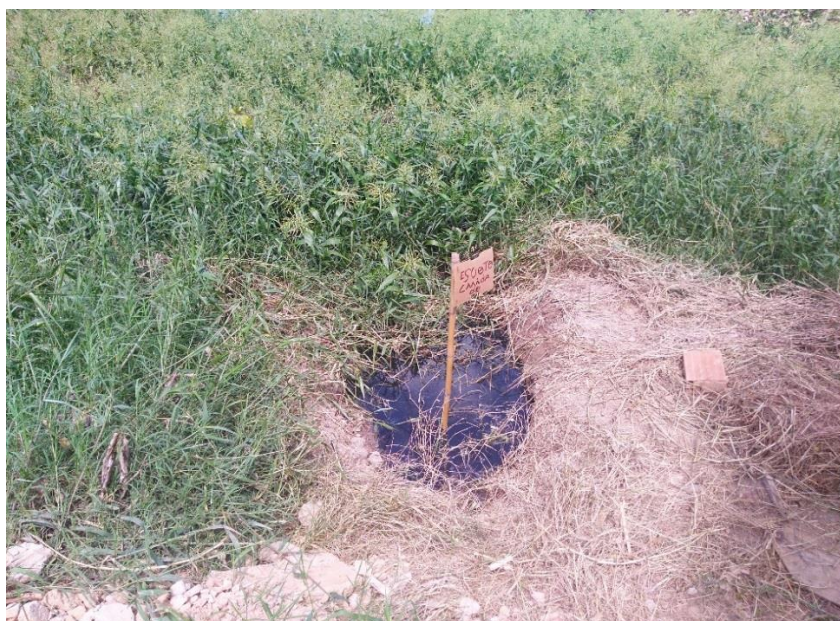
Figura 32. Esgoto lançado in natura no município de Carapebus/RJ. Foto de José Ricardo Maia.
