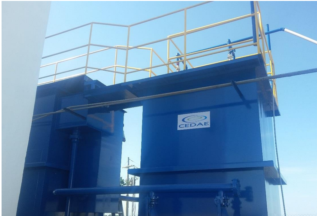
Figura 13. Registro da Estação de Tratamento de Água de Carapebus/RJ. Fonte: Equipe Técnica (2019).
