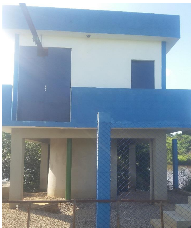
Figura 10. Casa de bomba da estação elevatória do Córrego Grande. Fonte: Equipe Técnica (2019).
