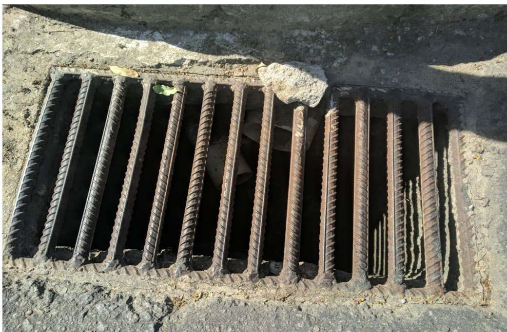
Figura 71. Tubos PVC clandestinos, provenientes de esgoto doméstico ligados à rede de microdrenagem municipal. Fonte: Equipe Técnica (2019).
