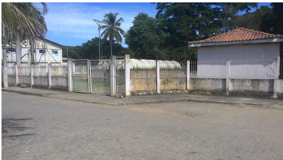
Figura 34. Vista geral da Estação de Tratamento de Ubás. Fonte: Equipe Técnica (2019).
