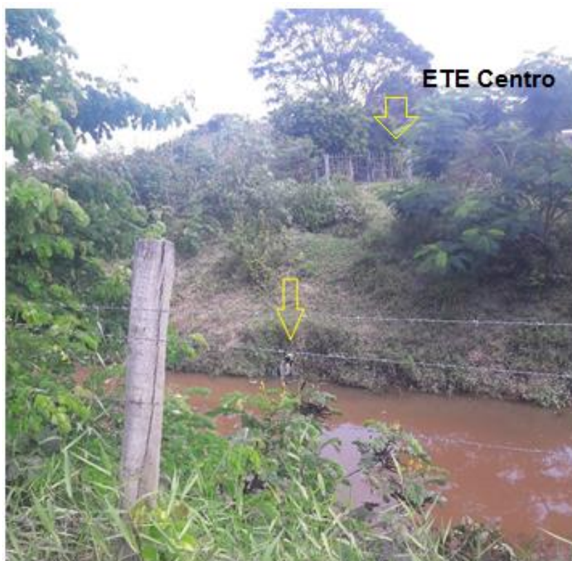
Figura 38. Ponto de lançamento do efluente após tratamento na Estação de Tratamento de Esgoto do Centro. Fonte: Equipe técnica (2019).
