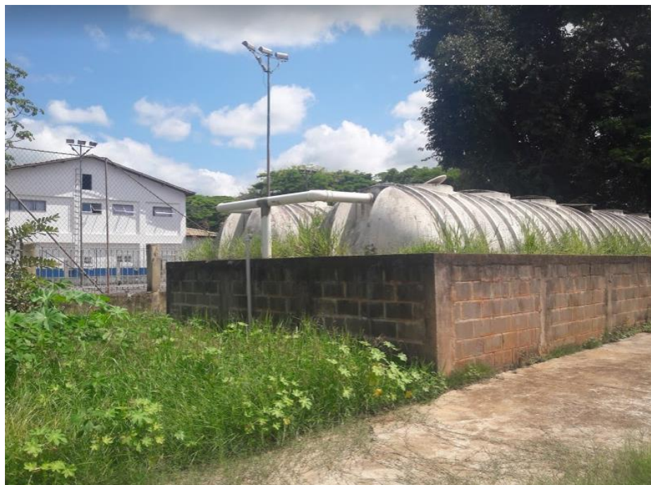
Figura 36. Estado dos reatores, coberto por vegetação. Fonte: Equipe Técnica (2019).
