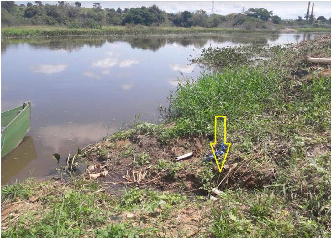
Figura 24. Ponto de lançamento de esgoto in natura às margens do córrego da Maricota. Fonte: Equipe Técnica (2019).
