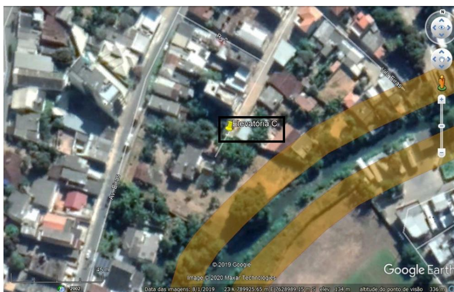
Figura 14. Localização da Estação Elevatória C em Miracema/RJ. Fonte: Google Earth, 2020
