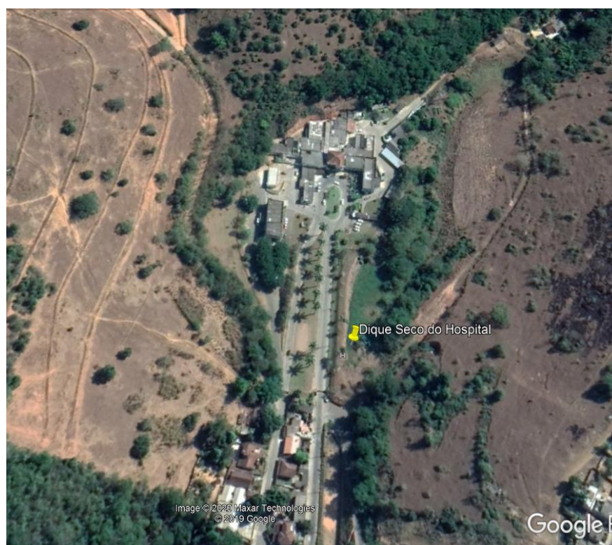
Figura 40. Localização do dique seco do Hospital de Miracema/RJ. Fonte: Google Maps, 2020
