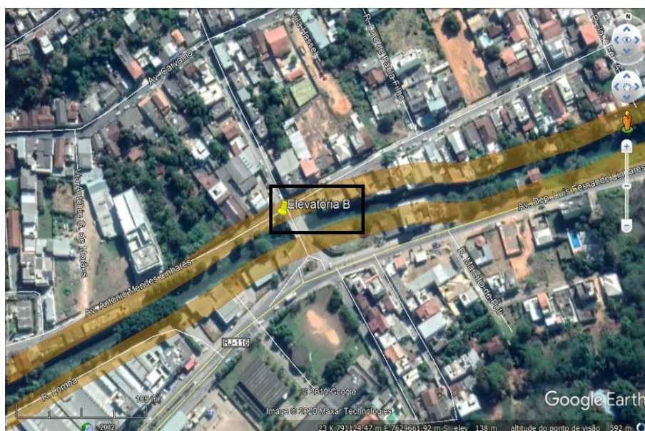
Figura 13. Localização da Estação Elevatória B em Miracema/RJ. Fonte: Google Earth, 2020
