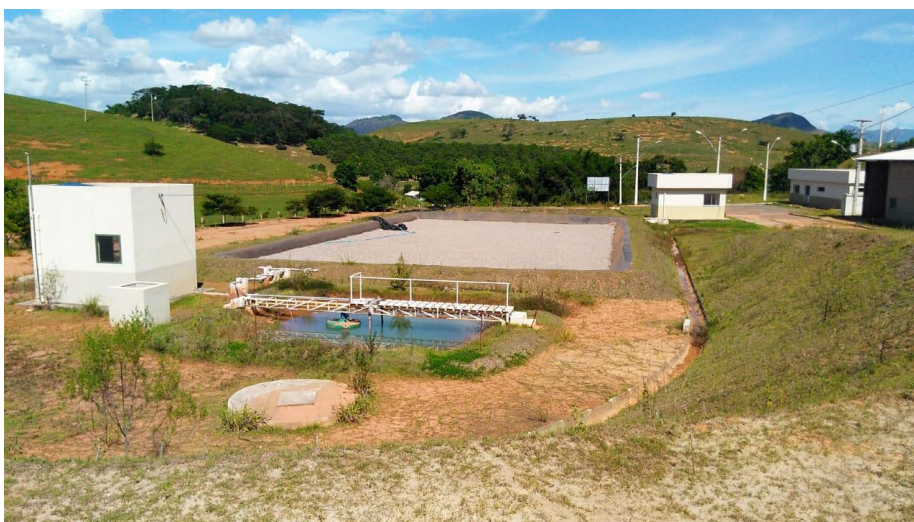
Figura 52 Estruturas do aterro sanitário São Fidélis. Fonte: Arquivo da Prefeitura, 2020.
