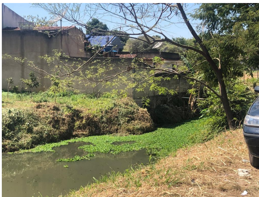
Figura 11. Trecho do Ribeirão Santo Antônio, na área urbana em Miracema/RJ. Fonte: Arquivo pessoal, 2019.
