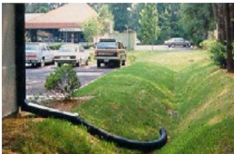
Figura 11. Vala de infiltração. Fonte: PHA - USP, 2008
