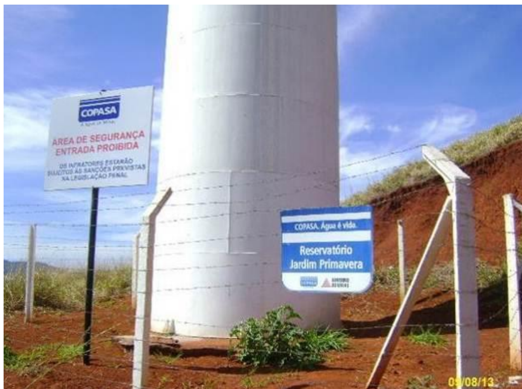
Figura 20– Reservatórios Jardim Primavera (100m 3 ). Fonte: DRZ - Gestão Ambiental
