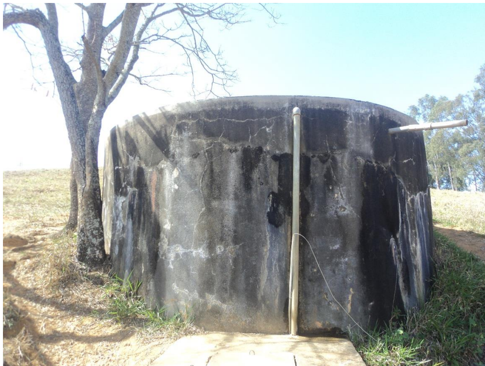
Figura 35 - Reservatório semi-enterrado (30m 3 ) Fonte: DRZ-Gestão Ambiental
