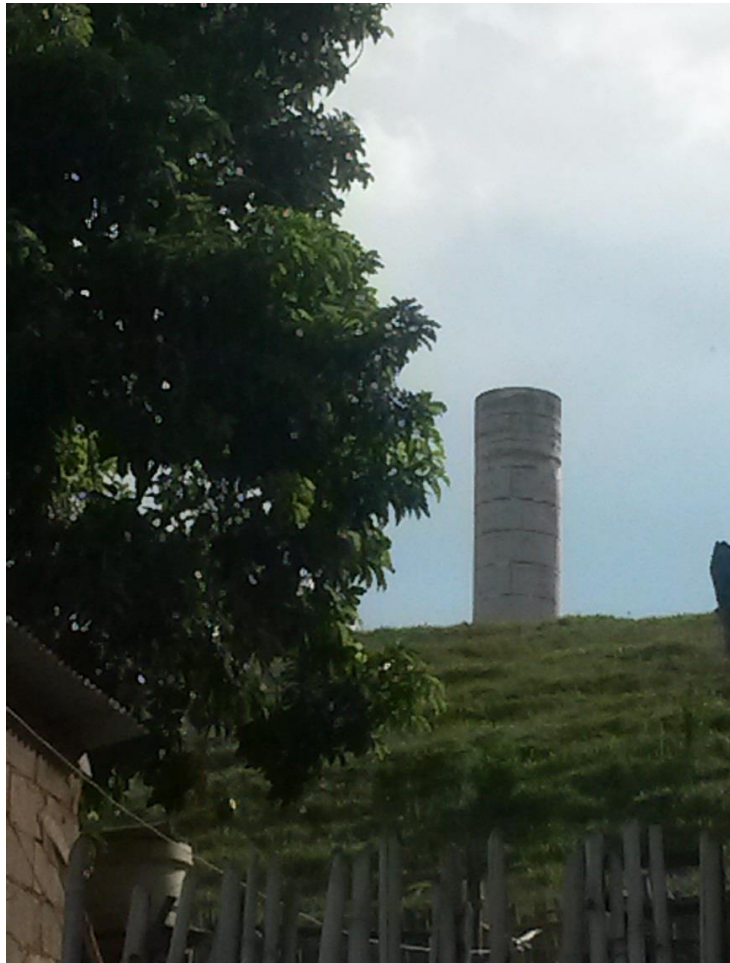
Figura 34 - Reservatório apoiado (100m 3 ) Fonte: DRZ-Gestão Ambiental
