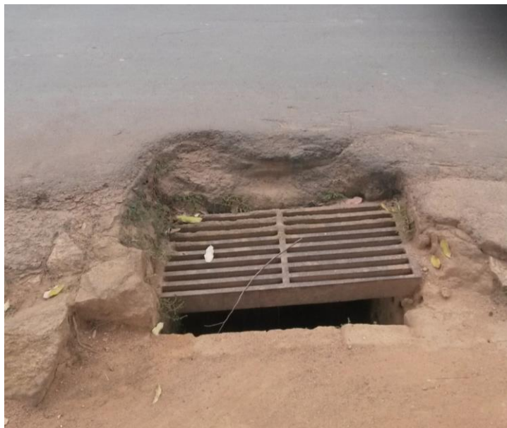
Figura 47 - Estrutura de captação do tipo grelha no Distrito Sede Fonte: DRZ – Gestão Ambiental
