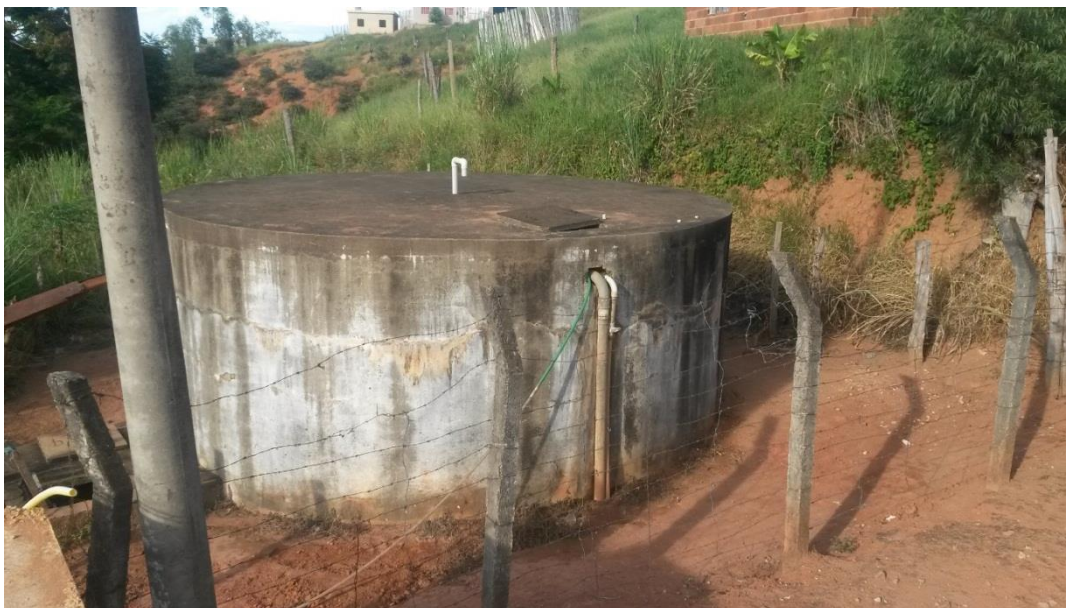
Figura 27 - Reservatório semi-enterrado (70m³).
