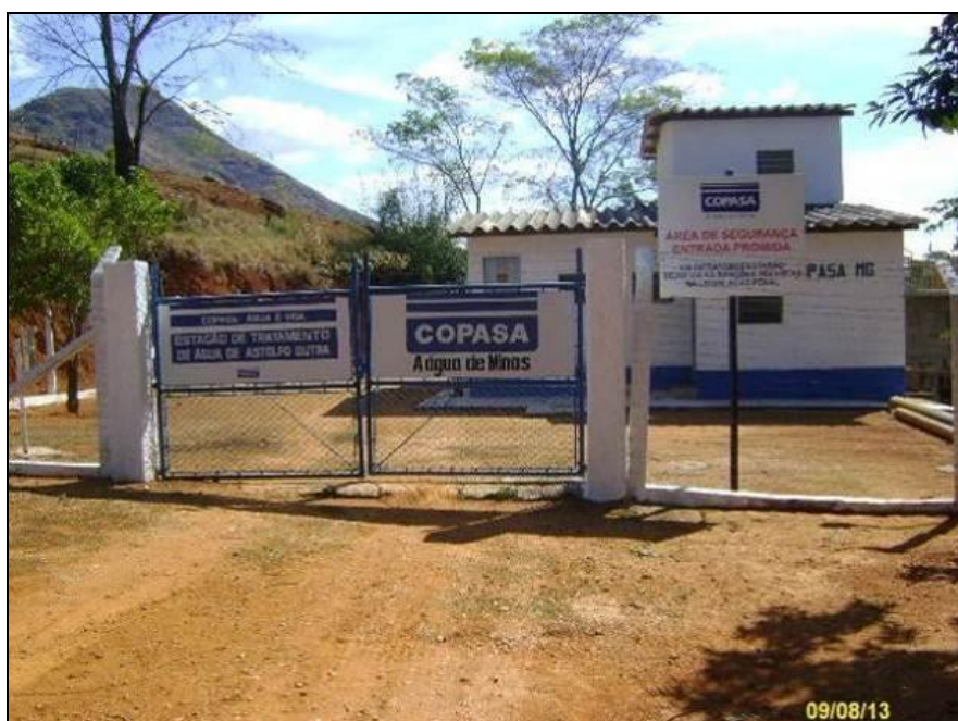
Figura 13– Entrada da estação de tratamento de água
