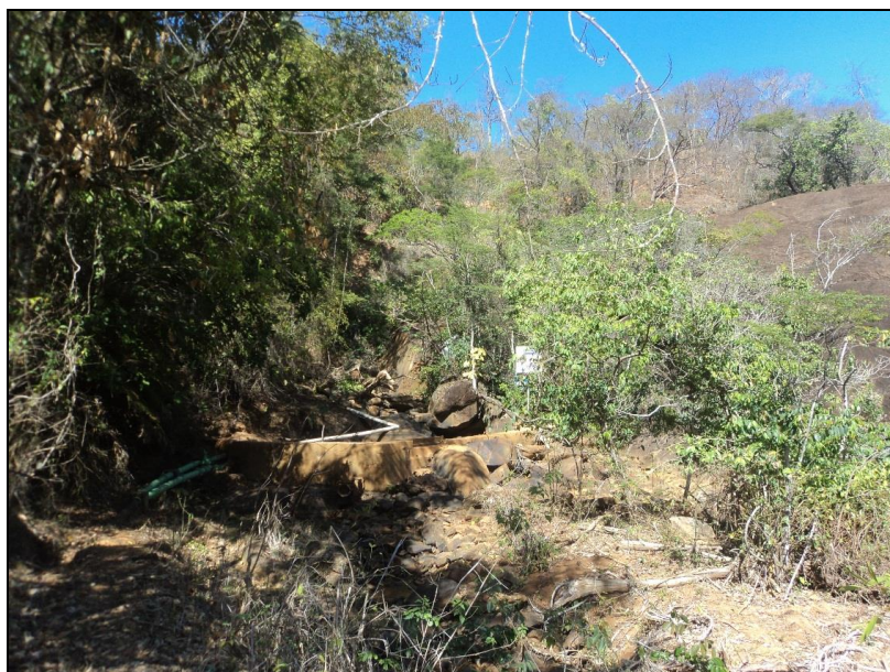
Figura 8 - Barragem da captação de água bruta em Astolfo Dutra – MG.
