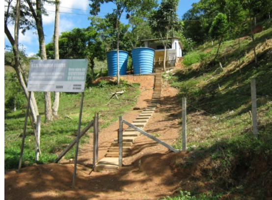
Figura 32 – Acesso a ETA.
