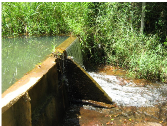
Figura 23 – Barragem de nível vista 1.
