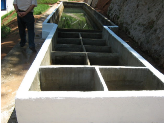
Figura 31 – Unidades de tratamento.
