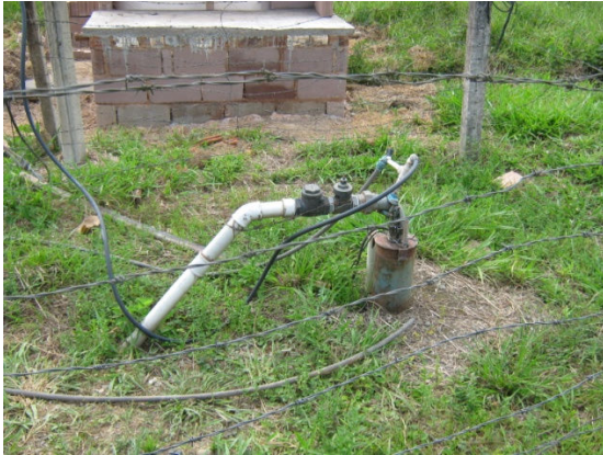
Figura 25 – Vista do Poço 1.
