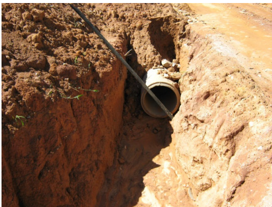
Figura 53 – Implantação de rede pluvial vista 1.
