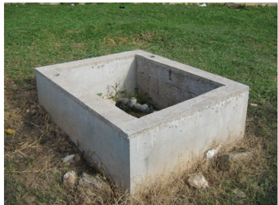
Figura 28 – Vista do Poço 2.
