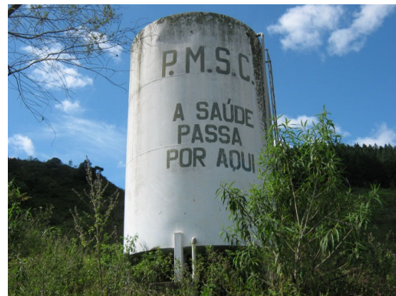
Figura 40 – Reservatório bairro Novo Horizonte vista 2.
