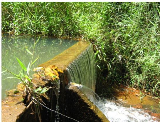
Figura 24 – Barragem de nível vista 2.
