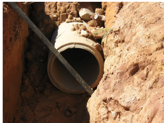
Figura 54 – Implantação de rede pluvial vista 2.
