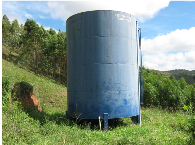
Figura 38 – Reservatório Rua Vereador José Gervázio vista 2.
