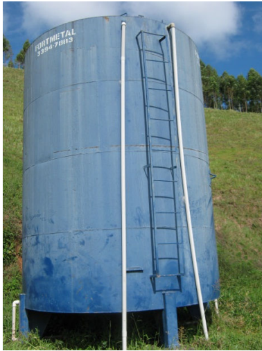
Figura 37 – Reservatório Rua Vereador José Gervázio vista 1.
