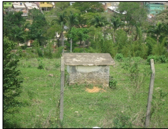
Figura 35- Casa de Manobras
