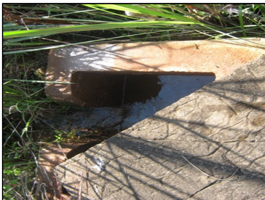
Figura 20– Caixa de captação
