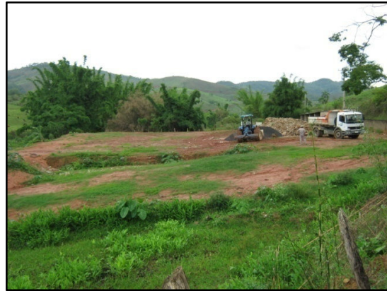
Figura 38- Vista geral do aterro desativado
