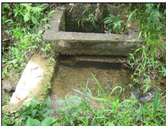
Figura 12- Caixa de Captação Det.1.
