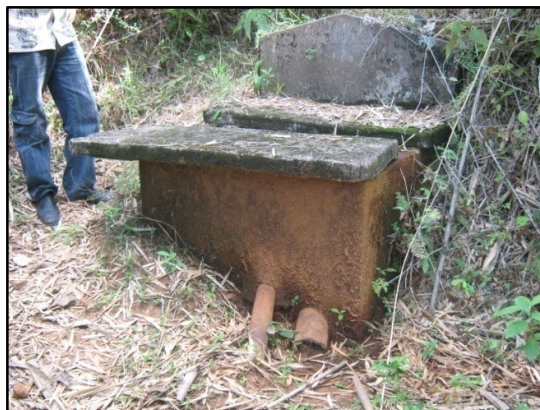
Figura 21– Caixa de captação
