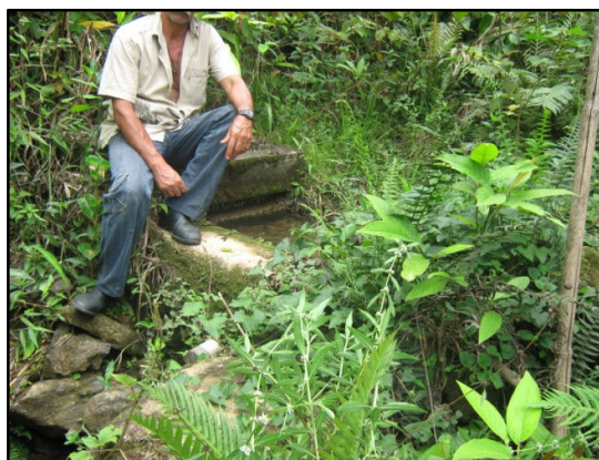
Figura 13 - Caixa de Captação Det.2.
