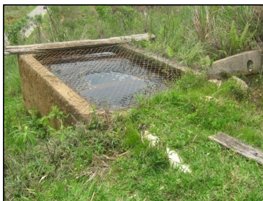
Figura 19– Caixa de passagem abaixo da captação
