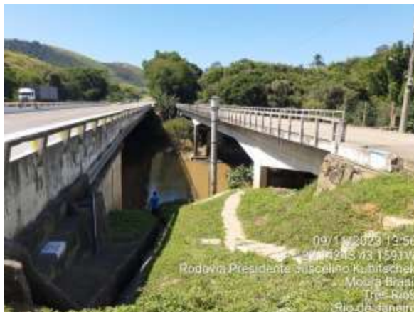
Figura 4.180. RJ11 - Local de acesso.
