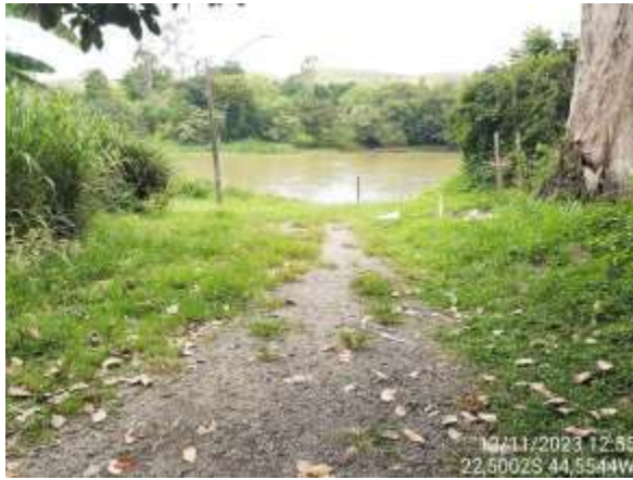
Figura 4.124. RJ02 - Local de acesso.
