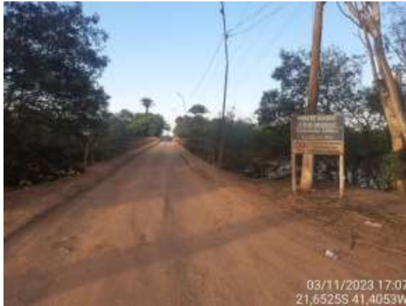
Figura 4.78. RJ23 - Acesso ao local de medição
