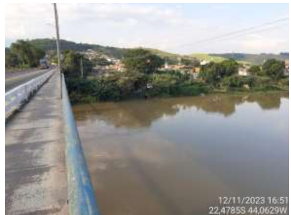
Figura 4.21. RJ05 - Margem esquerda.
