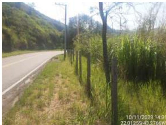
Figura 4.115. RJ30 - Cercamento dificultando o acesso ao local.
