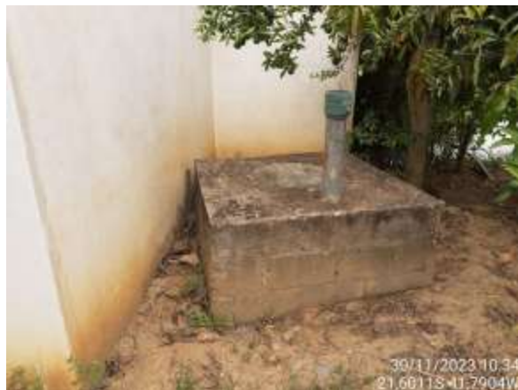
Figura 4.242. RJ20 - Condições externas da estrutura de monitoramento de qualidade.
