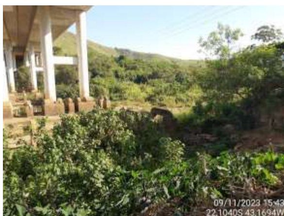
Figura 4.35. RJ10 - Local de difícil acesso.
