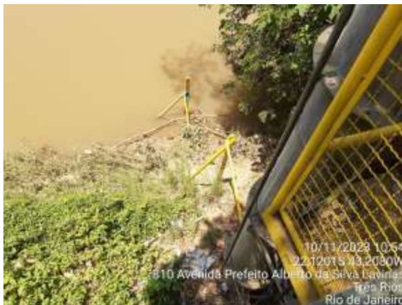
Figura 4.170. RJ09 - Régua limnimétrica.
