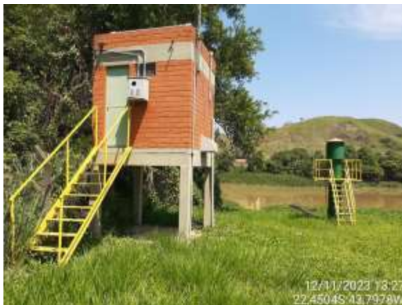
Figura 4.156. RJ07 - Vista externa.
