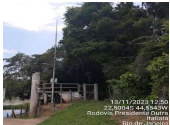
Figura 4.129. RJ02 - Vista externa da PCD.
