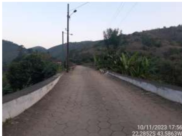
Figura 4.292. Ponte São Sebastião Lacerda
