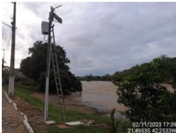
Figura 4.262. RJ29 - Localização da estação.
