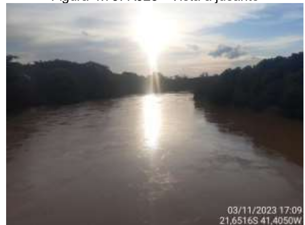
Figura 4.81. RJ23 - Vista da ponte.
