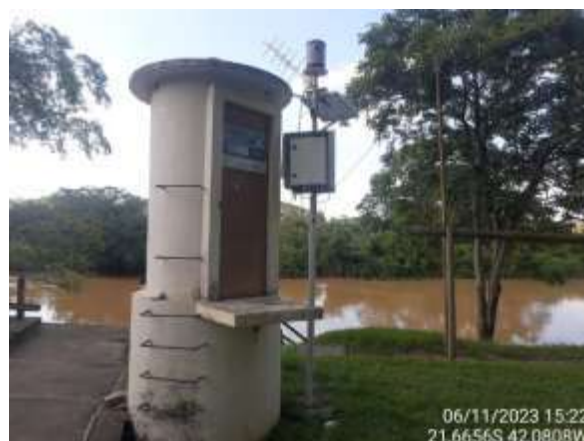
Figura 4.60. RJ17P1 - Vista externa da PC.
