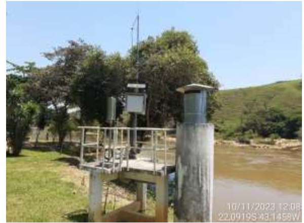
Figura 4.190. RJ13 - Estação de monitoramento.
