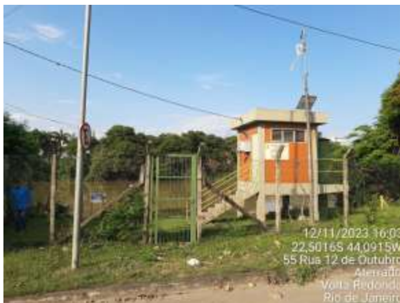
Figura 4.134. RJ03 - Local de acesso.
