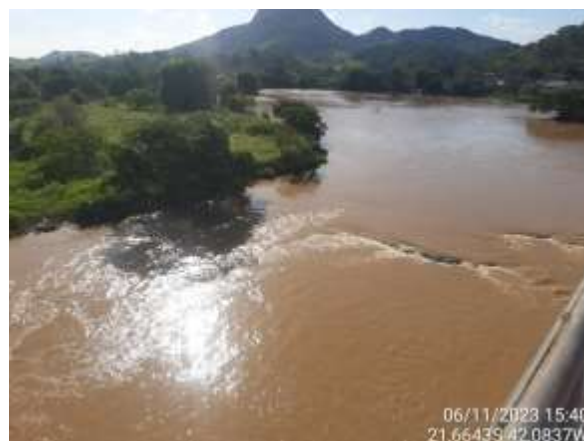
Figura 4.64. RJ17P1 - Impeditivo para a realização da medição de vazão.
