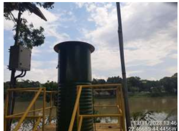
Figura 4.289. Resende - Vista externa da PCD(LIGHT).
