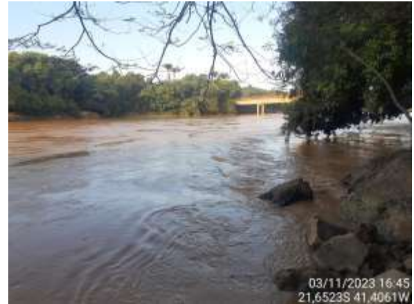
Figura 4.79. RJ23 - Vista a jusante
