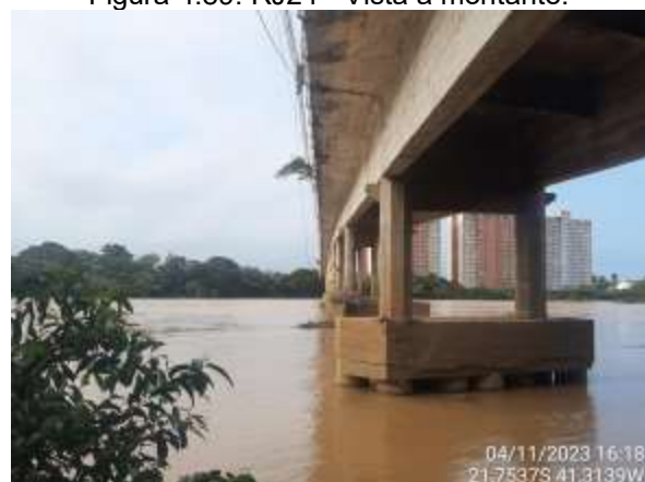
Figura 4.91. RJ24 - Estrutura da ponte
