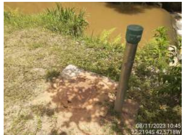
Figura 4.207. RJ15 - Condições da estrutura de monitoramento da qualidade da água.
