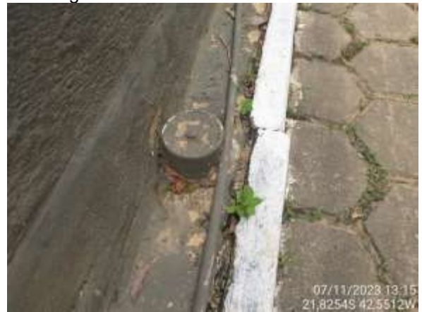
Figura 4.57. RJ14 - Estrutura de RN sem referência.
