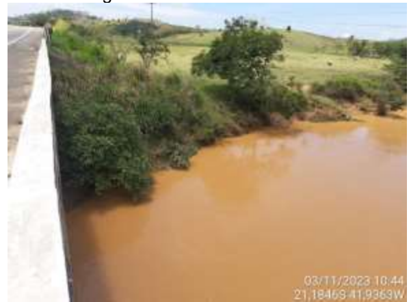
Figura 4.107. RJ26 - Margem esquerda.
