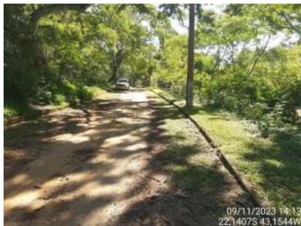
Figura 4.182. RJ11 - Local de acesso.
