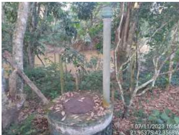
Figura 4.218. RJ16 - Condições estrutura de monitoramento de qualidade da água.
