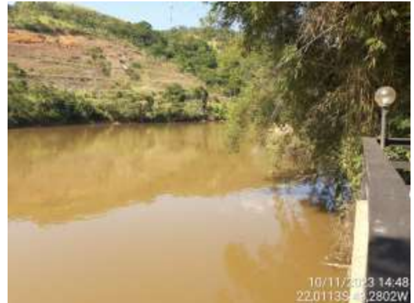
Figura 4.119. RJ30 - Vista a montante.
