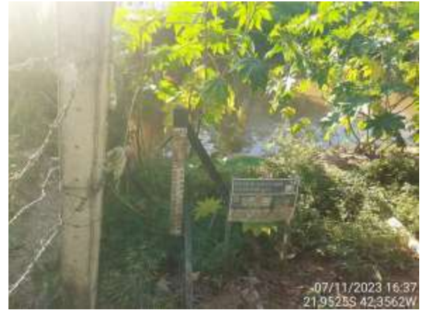
Figura 4.215. RJ16 - Régua limnimétrica.
