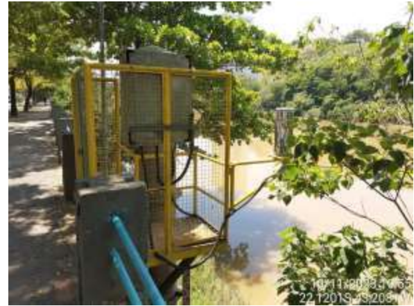
Figura 4.167. RJ09 - Vista externa estação.
