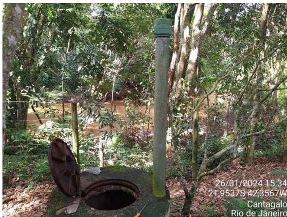
Figura 2.31. RJ16 – Condições da estrutura de monitoramento de qualidade da água.
