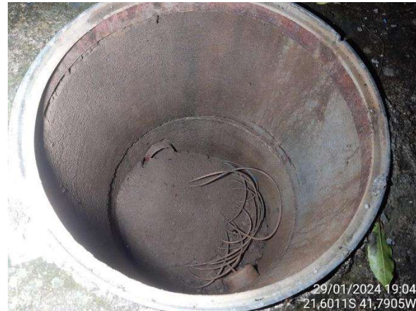
Figura 2.43. RJ20 – Gabinete da estação.
