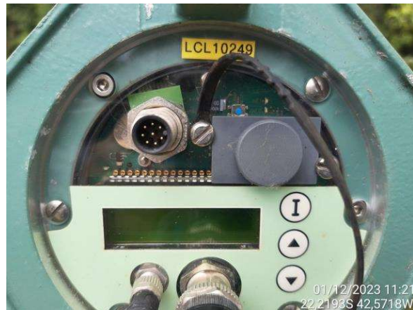
Figura 2.10. RJ15 - Vista interna da PCD.
