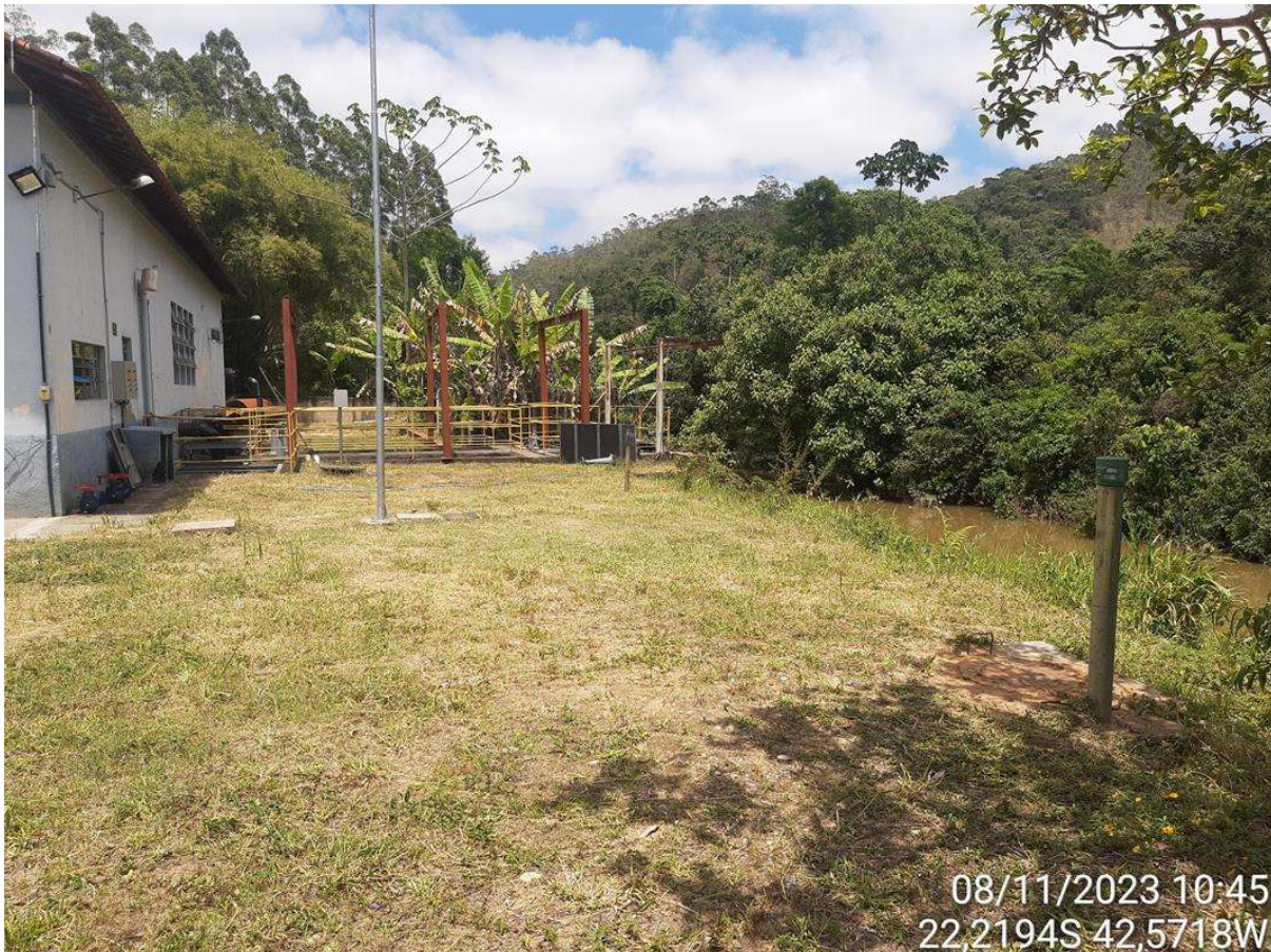
Figura 2.4. RJ15 – Vista externa da estação.
