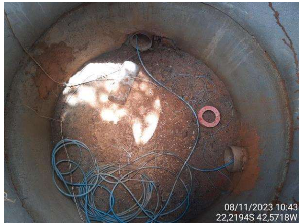
Figura 2.6. RJ15 - Condição interna do gabinete.
