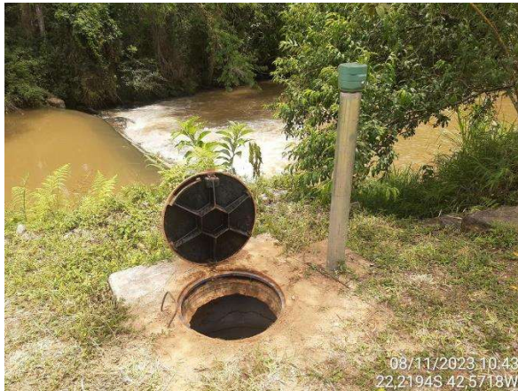
Figura 2.5. RJ15 – Estrutura de monitoramento da qualidade da água.
