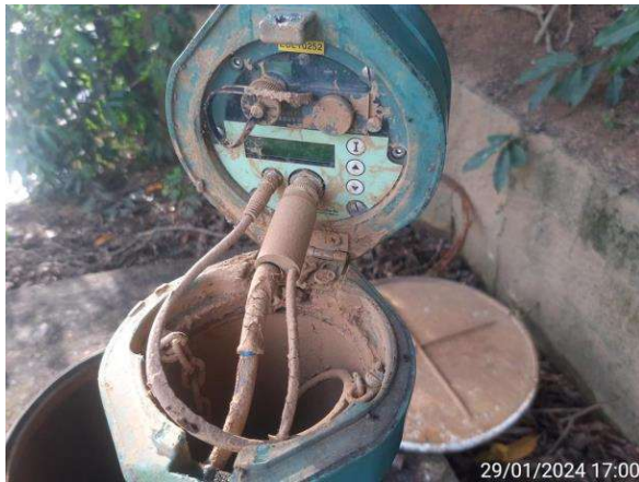
Figura 2.52. RJ25 – Vista interna da PCD.
