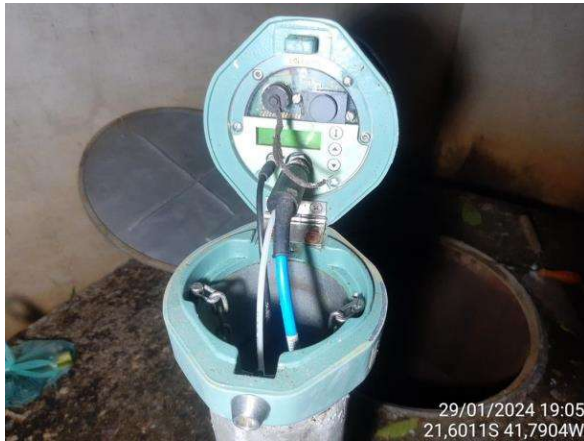
Figura 2.42. RJ20 – Vista interna da PCD.
