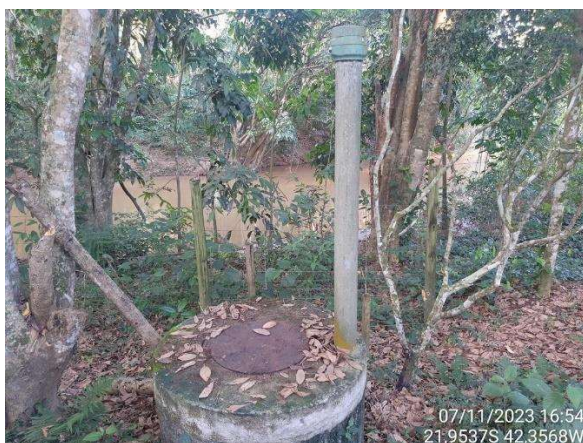
Figura 2.29. RJ16 - Vista externa da estação.
