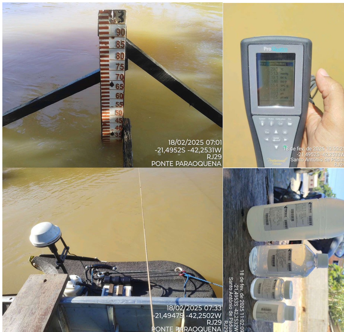
Figura 4.58. Registros fotográficos do ponto RJ29 - Ponte Paraoquena, destacando a seção de medição, a medição de vazão e de parâmetros de qualidade da água, e a coleta de amostras de água.
