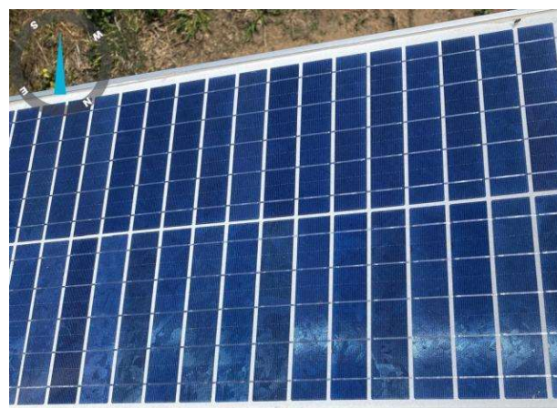
Figura 2.4 - Placa solar após limpeza
