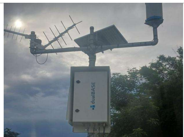
Figura 2.2- Vista externa da PCD.
