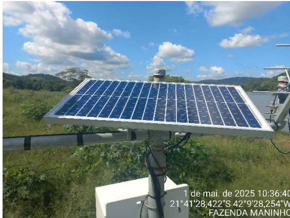
Figura 2.11 Limpeza da placa solar.
