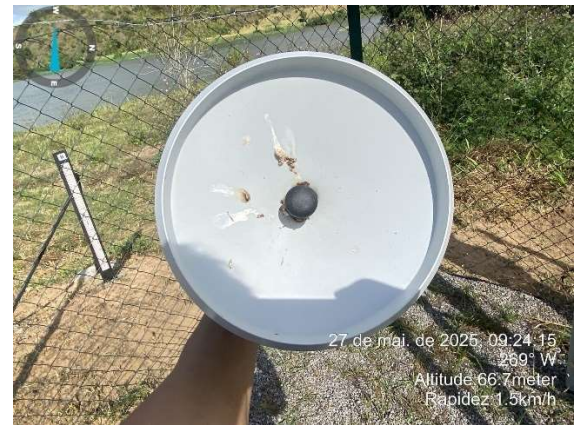
Figura 2.12 - Pluviômetro antes da limpeza
