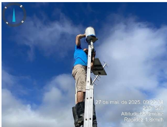
Figura 2.13 - Limpeza o pluviômetro.
