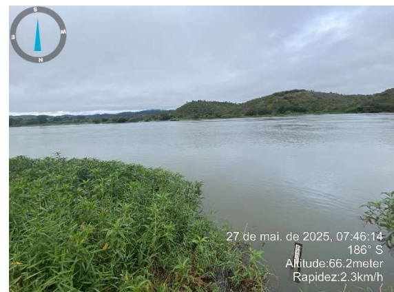
Figura 2.4 - Vista do rio a jusante.
