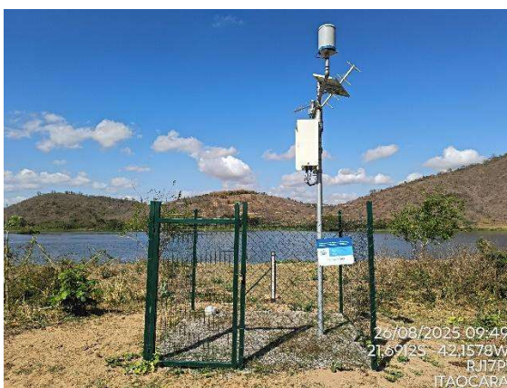
Figura 2.3 - Vista externa da PCU.
