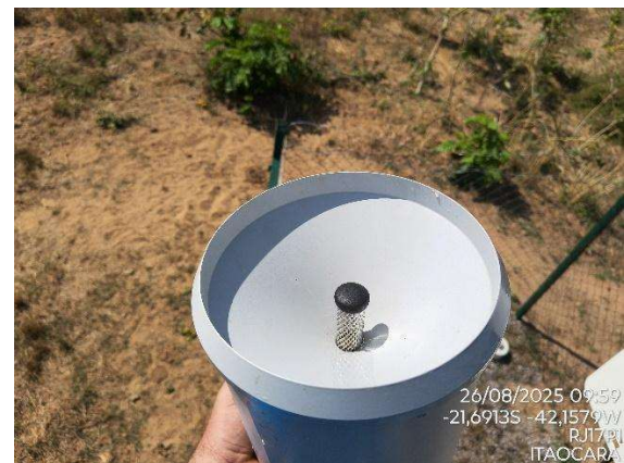
Figura 2.8 - Pluviômetro após a limpeza.
