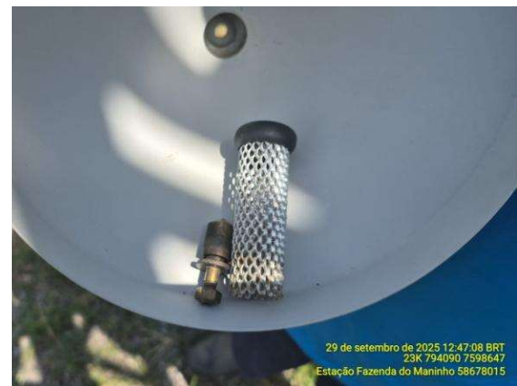
Figura 2.8 - Pluviômetro após a limpeza.
