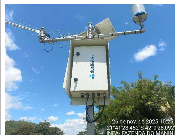
Figura 2.3 - Vista externa da PCD.
