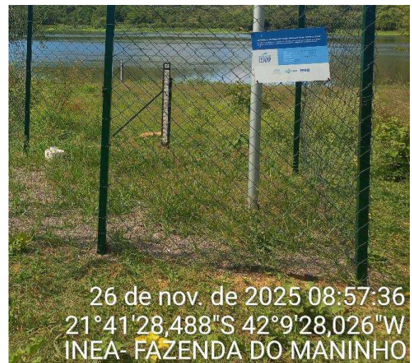
Figura 2.8 - Placa de identificação da estação.
