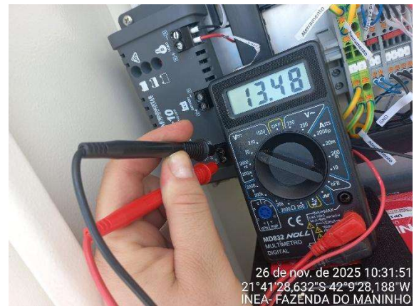
Figura 2.6 – Teste de voltagem.
