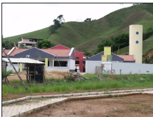
Figura 4 - Creche em construção
