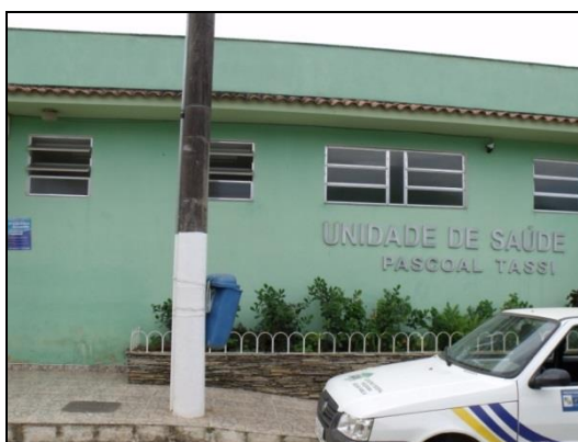
Figura 5 – Fachada da UBS
