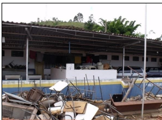
Figura 23 – Local de armazenamento dos pneus na garagem da prefeitura
