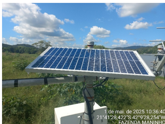
Figura 2.11 Limpeza da placa solar.
