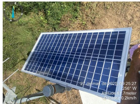
Figura 2.10 - Limpeza da placa solar.
