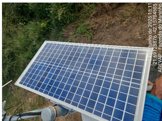
Figura 2.5 - Limpeza da placa solar
