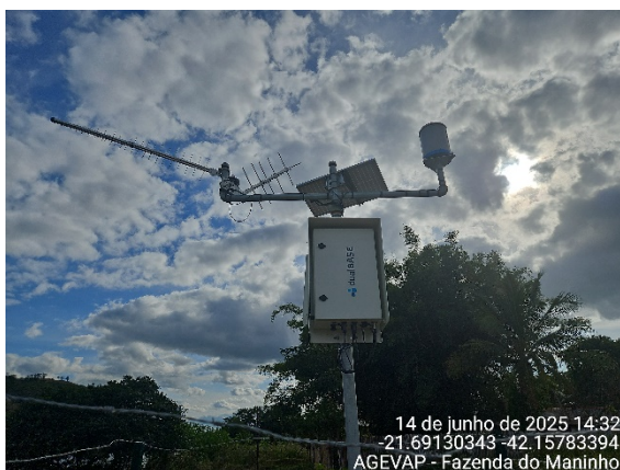
Figura 2.3 - Vista externa da PCD.
