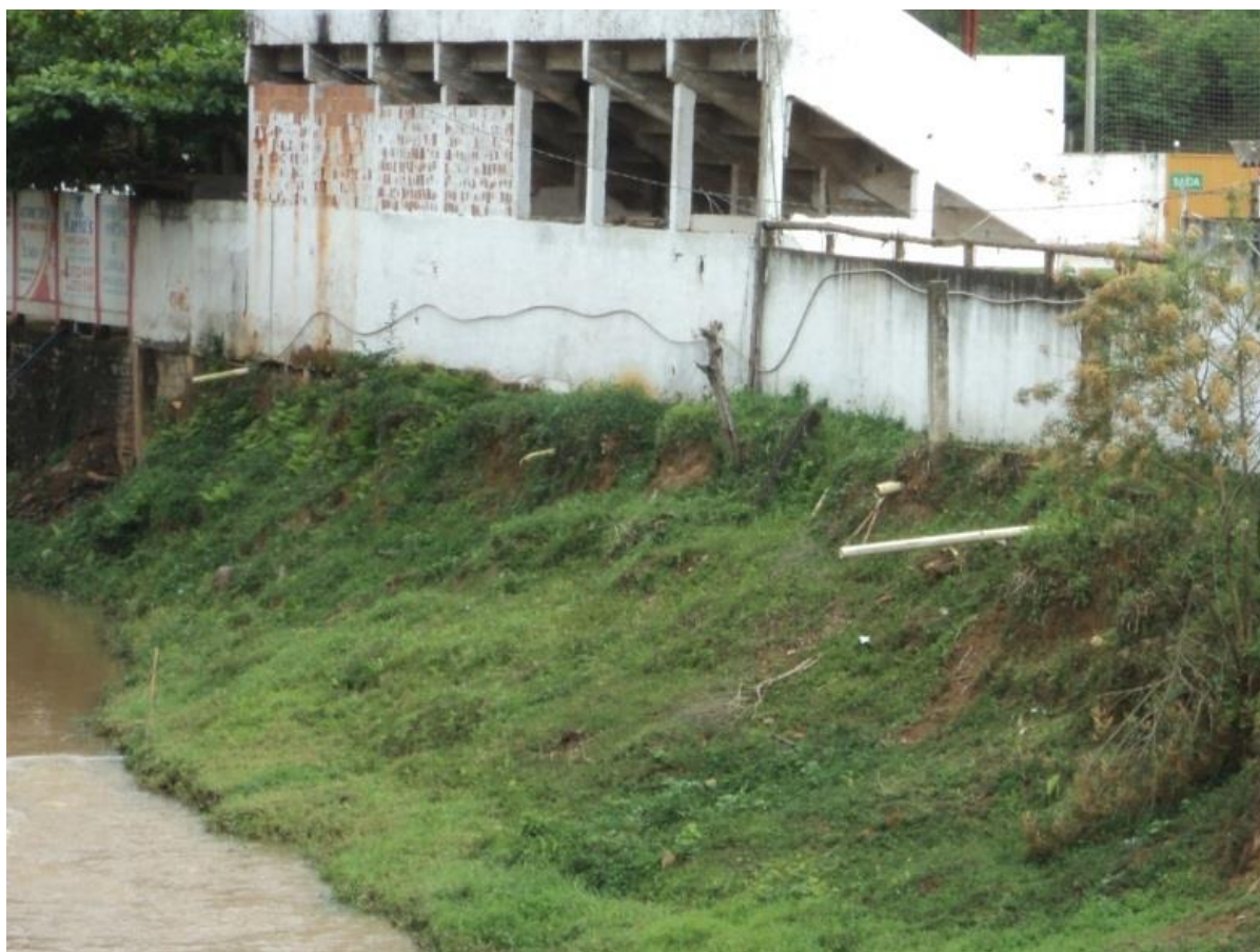
Figura 14 - Pontos de lançamento de esgoto in natura no distrito Sede – Ribeirão São João Fonte: DRZ Gestão Ambiental
