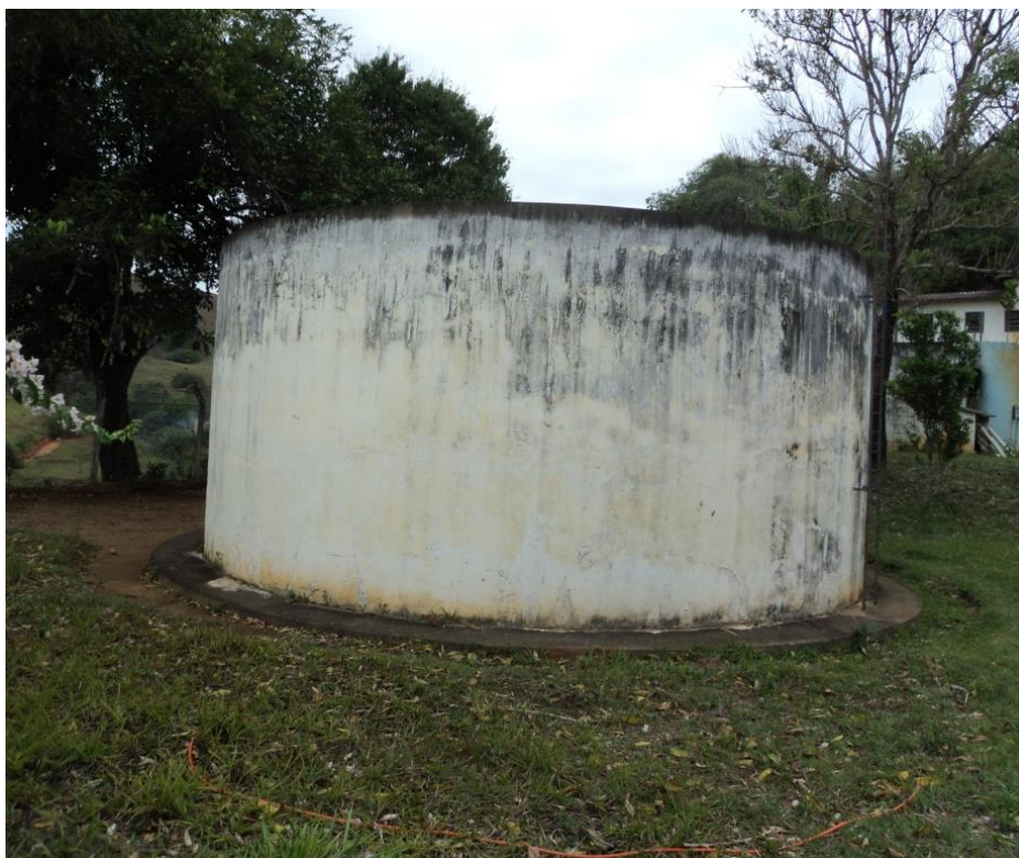
Figura 22 – Reservatório apoiado de 180 m 3 da estação de tratamento de água
