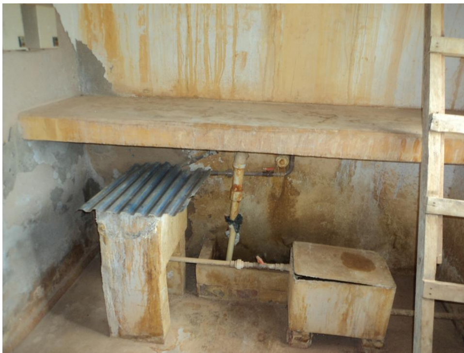
Figura 19 - Sala de cloração Fonte: DRZ - Gestão Ambiental
