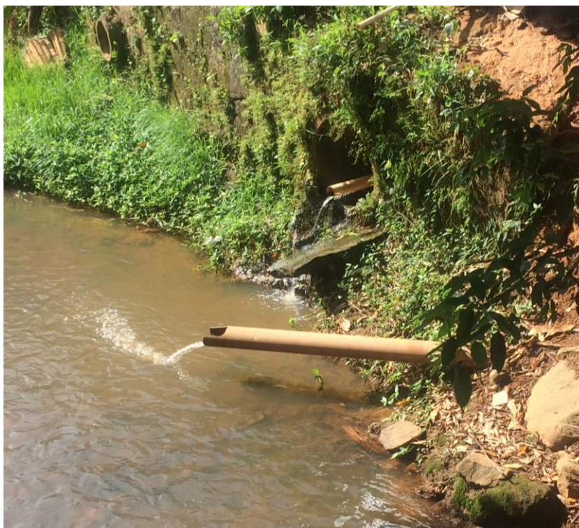
Figura 25 – Lançamento de efluente de esgoto doméstico in natura Fonte: DRZ - Gestão Ambiental
