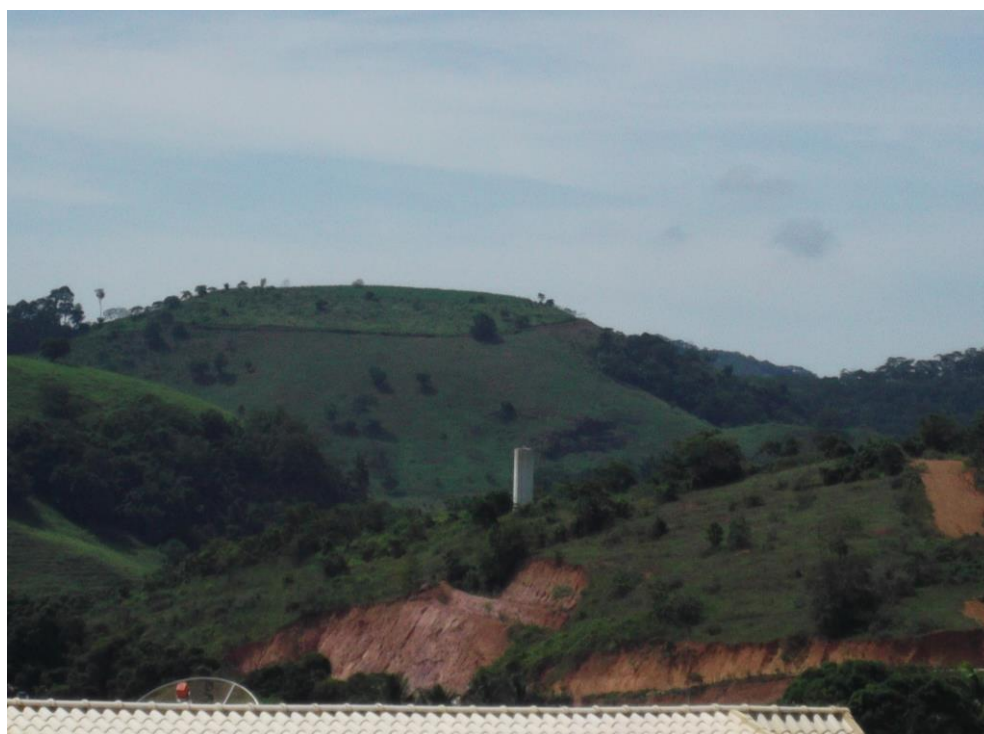
Figura 24 – Reservatório elevado de 100 m 3 Fonte: DRZ - Gestão Ambiental
