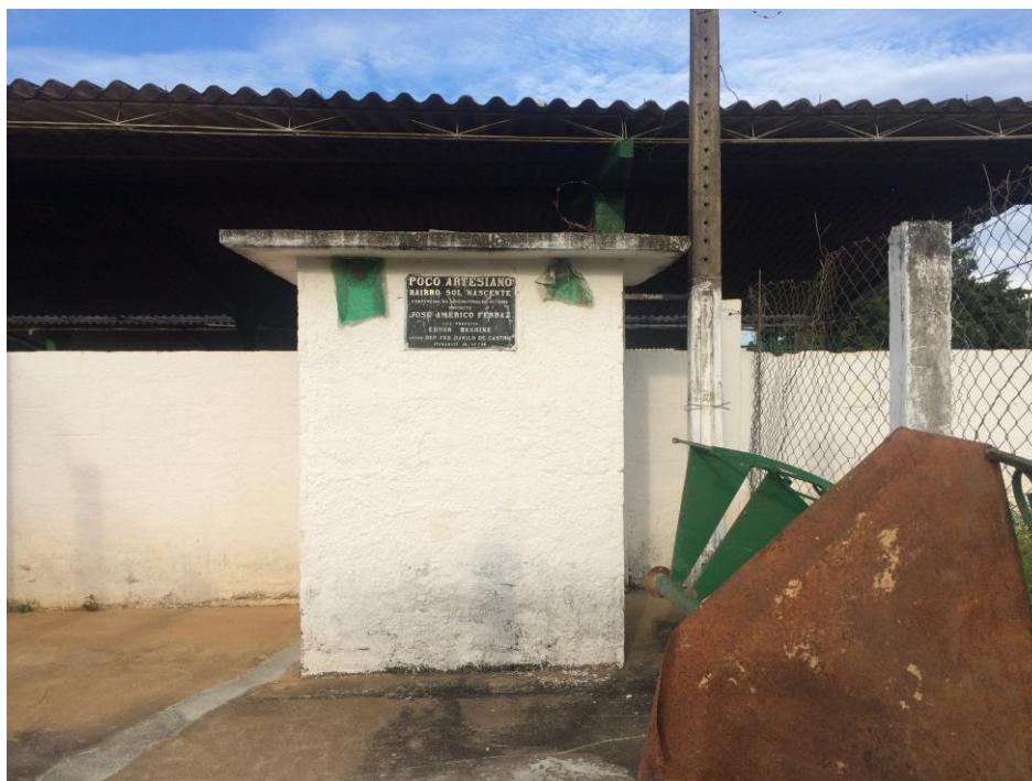
Figura 7 - Captação subterrânea 1 - Sol Nascente Fonte: DRZ – Gestão Ambiental
