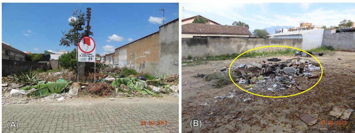
Figura 69 – Descarte irregular de RCC: (A) Terreno baldio no Bairro Liberdade com placa indicativa da proibição de descarte de resíduos, onde se observa RCC e outras tipologias descartadas; (B) Terreno baldio próximo ao Parque do Tobogã onde foi verificado descarte de restos de construção civil.
