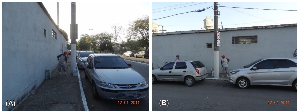
Figura 31 – Serviço de pintura de meio-fios e postes: (A e B) Funcionários da Prefeitura Municipal realizando a pintura de meio-fios e postes nas imediações da Prefeitura Municipal.
