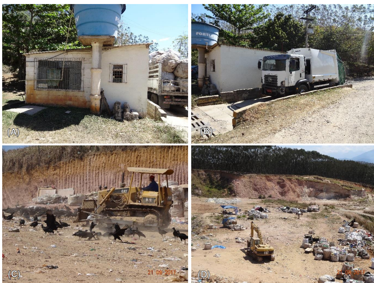
Figura 26 – Infraestrutura operacional do aterro controlado: (A) Guarita e local com instalações de apoio para os funcionários do aterro; (B) Balança rodoviária para controle do fluxo de resíduos sólidos; (C) Trator esteira utilizado para o manejo e compactação dos resíduos; (D) Retroscavadeira visualizada na área do aterro controlado.
