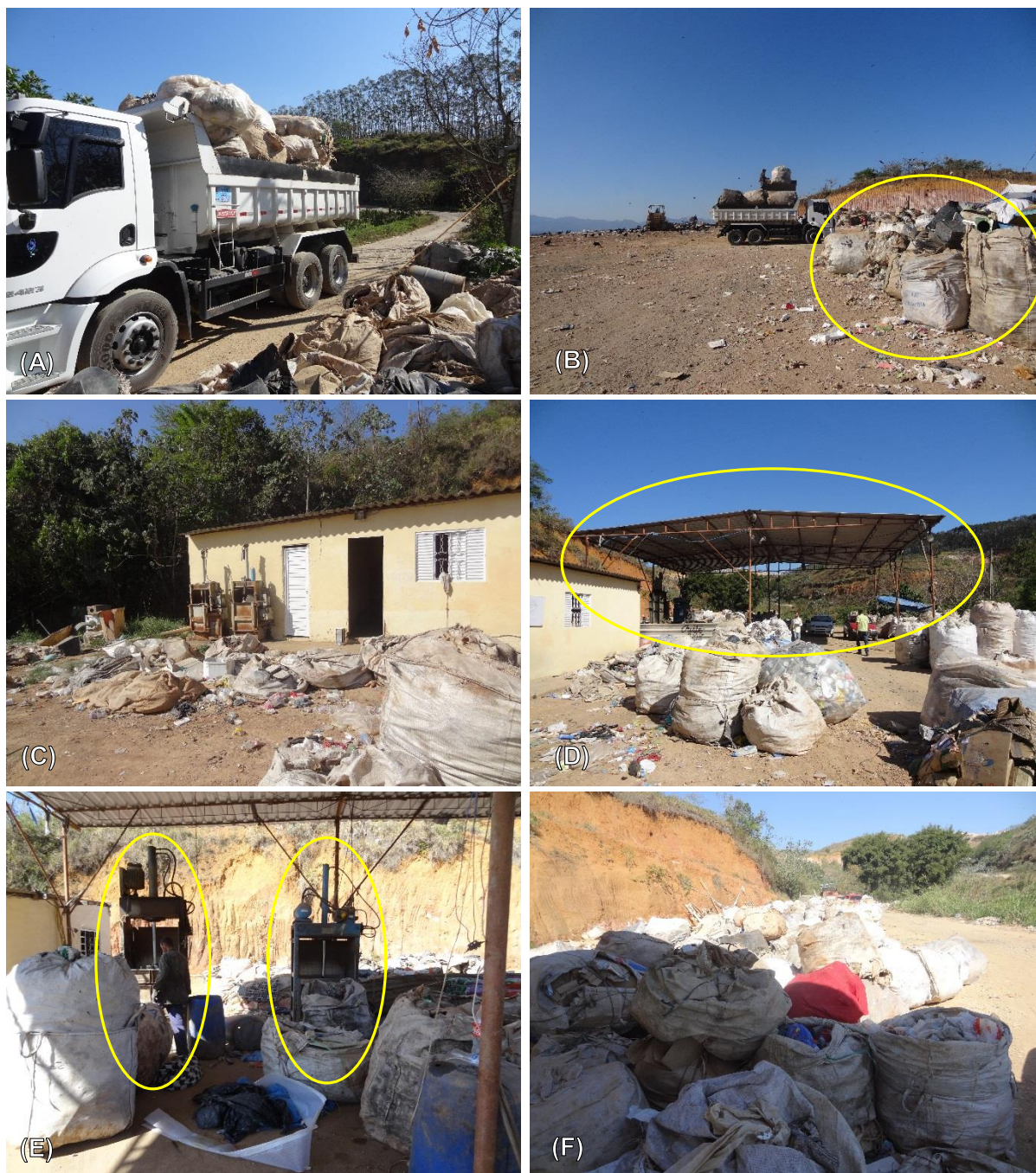
Figura 18 – Infraestrutura da AGASAR: (A) Caminhão utilizado para as operações do aterro controlado, contratado pela Prefeitura Municipal realizando o carregamento dos bag's do maciço até o galpão; (B) Vista da frente de trabalho na área de disposição de resíduos no aterro controlado, onde é possível observar os bag's utilizados para acondicionar os materiais triados; Vista da sala utilizada como escritório; (C) Prédio que abriga as instalações administrativas e de apoio; (D) Vista frontal do galpão que abriga o maquinário e temporariamente o material para comercialização; (E) Prensas verticais abrigadas no galpão da associação; (F) Área externa ao galpão utilizada para armazenar os materiais à serem prensados e enfardados.
