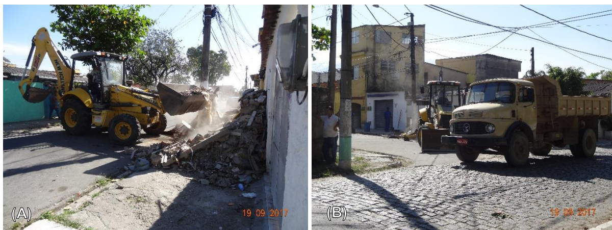
Figura 79 – Coleta de RCC realizada em mutirão na rua dos Ipês no Bairro Cidade Alegria: (A) Pá carregadeira recolhendo os RCC para carregar os caminhões que realizam o transporte. (B) Caminhão basculante carregado para transportar os RCC até o Aterro de Resíduos Verde e Construção Civil.
