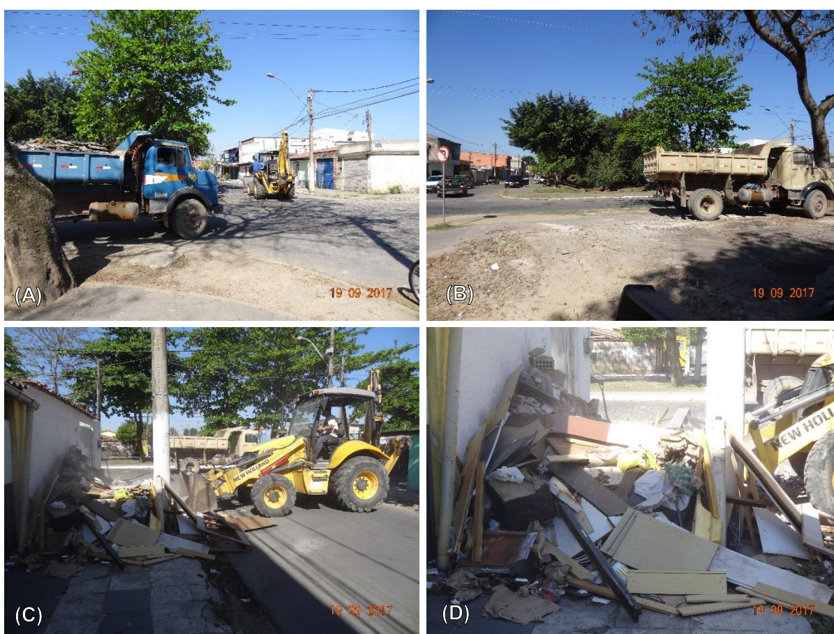
Figura 44 – Execução do serviço de coleta e transporte de RVol: (A e B) Remoção mecanizada de resíduos volumoso, entulhos e resíduos verdes realizado no Bairro Cidade Alegria; (C e D) Trator pá carregadeira e caminhões executando a remoção de RVol juntamente a outros resíduos no Bairro Cidade Alegria.
