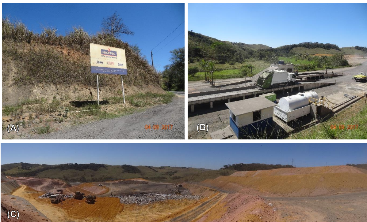
Figura 61 – Instalações do CTR Barra Mansa: (Placa de acesso ao aterro sanitário); (B) Vista das balanças rodoviárias de acesso; (C) Panorâmica dos maciços onde são dispostos os resíduos encaminhados para a destinação final (Classe II).
