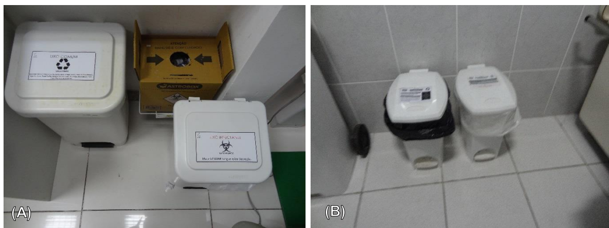
Figura 52 – Exemplo de disposição de recipientes para o descarte de resíduos comuns (Grupo D) e infectantes (Grupos A e E): (A) Recipientes para resíduos infectante, comum e perfurocortantes lado a lado em sala de atendimento em estabelecimento público de saúde; (B) Recipientes em sala de atendimento de unidade pública de saúde.
