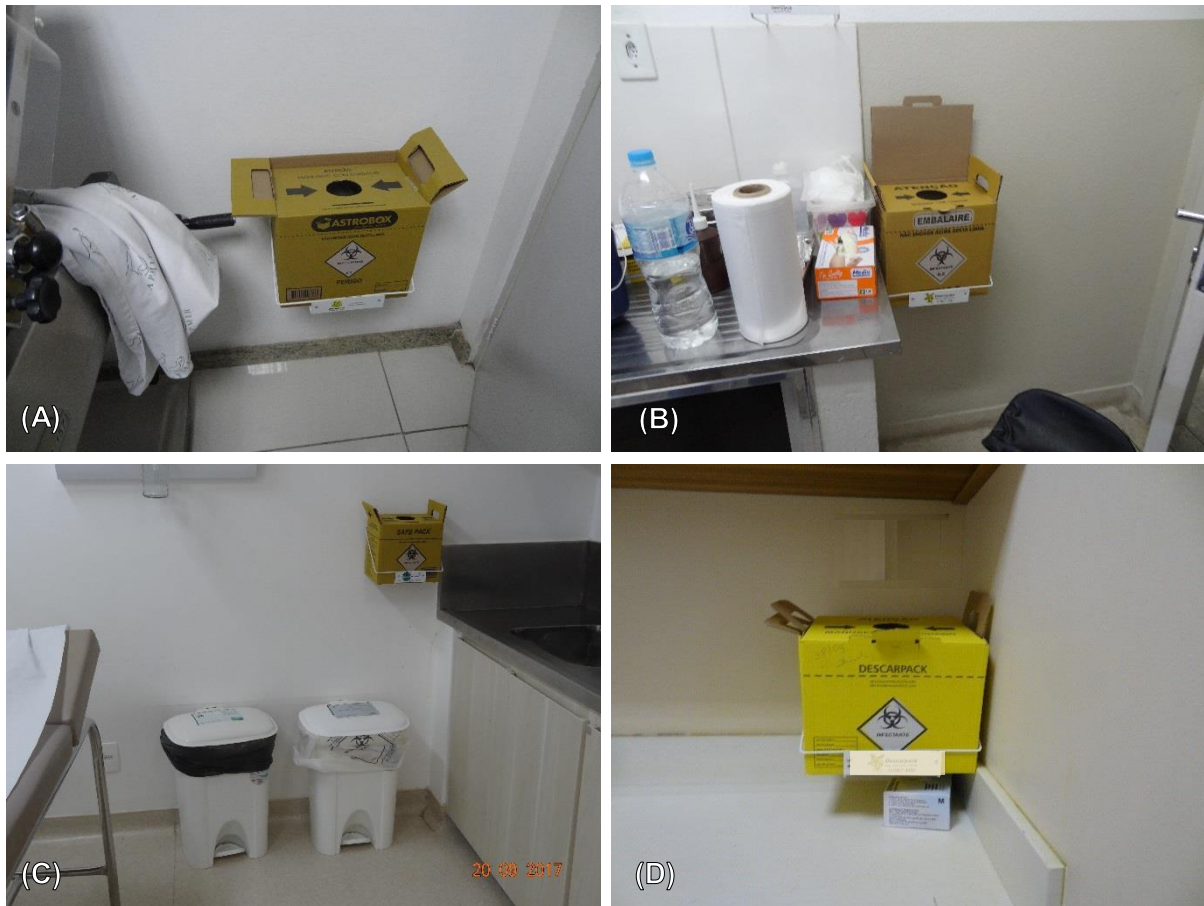
Figura 49 – Exemplo de acondicionamento interno dos resíduos perfurocortantes (Grupo E): (A) Sala de atendimento em estabelecimento público de saúde; (B) Sala de vacinação em estabelecimento público de saúde; (C) Leito de um estabelecimento particular de saúde; (D) Coletor para material perfurocortante em sala de atendimento de estabelecimento particular de saúde.
