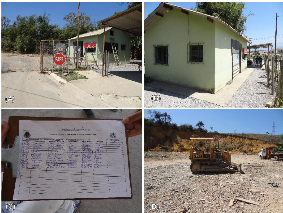
Figura 38 – Infraestrutura operacional do aterro de resíduos verdes e construção civil: (A) Vista do portão de entrada; (B) Guarita e local com instalações de apoio para os funcionários do aterro; (C) Planilha para controle do fluxo de veículos; (D) Trator esteira modelo D4 utilizado para o manejo dos resíduos.
