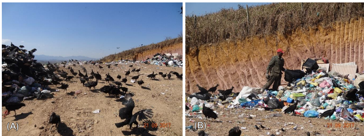
Figura 25 – Irregularidades constatadas na área do aterro controlado: (A) Presença significativa de aves (Urubus e Cárcaras); (B) Catação realizada diretamente nos resíduos vazados pelos caminhões compactadores na frente de operação.
