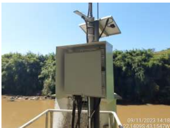
Figura 4.186. RJ11 - Vista externa PCD.
