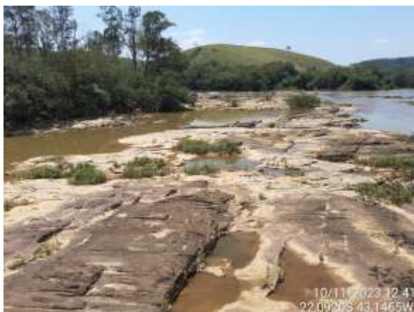
Figura 4.193. RJ13 - Lajes de pedra.
