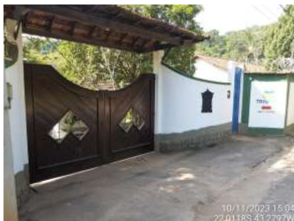
Figura 4.118. RJ30 - Acesso à propriedade.
