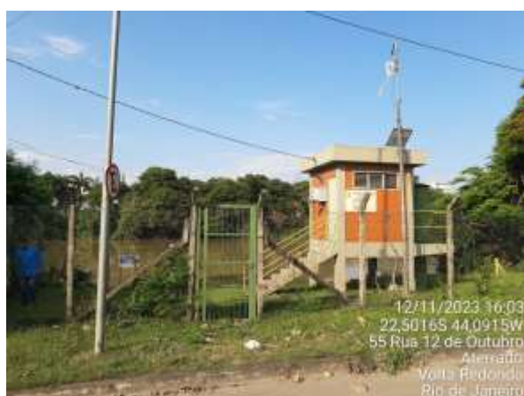
Figura 4.134. RJ03 - Local de acesso.
