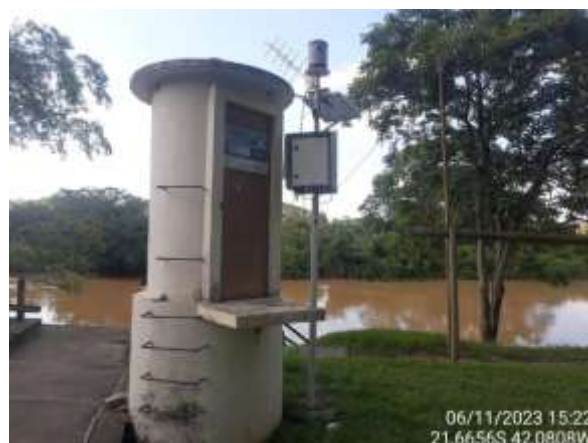
Figura 4.60. RJ17P1 - Vista externa da PCD.
