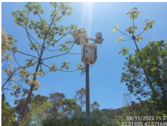
Figura 4.208. RJ15 - Vista externa PCD.
