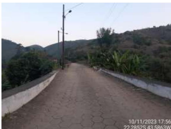
Figura 4.292. Ponte São Sebastião Lacerda
