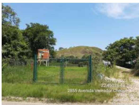
Figura 4.154. RJ07 - Local de acesso.
