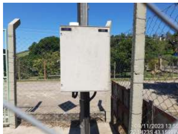
Figura 4.181. RJ11 - Vista externa PCD.
