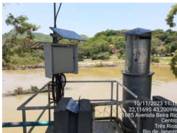
Figura 4.160. RJ09 - Vista externa da PCD.
