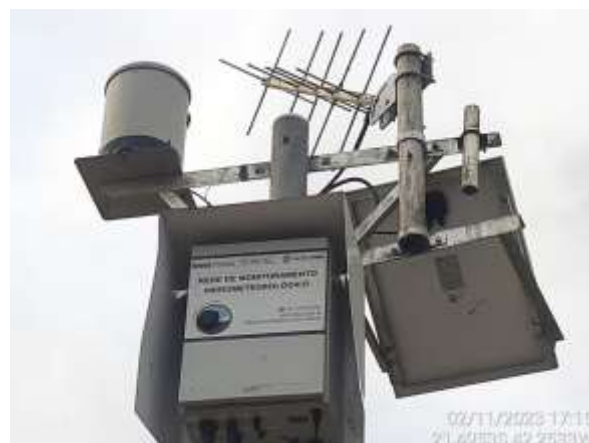
Figura 4.263. RJ29 - Vista externa PCD.
