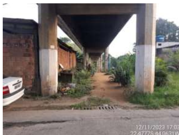
Figura 4.23. RJ05 - Acesso para o barco.
