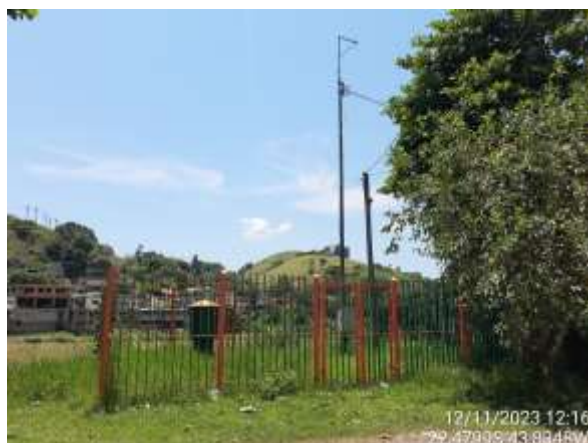
Figura 4.144. RJ06 - Local de acesso.
