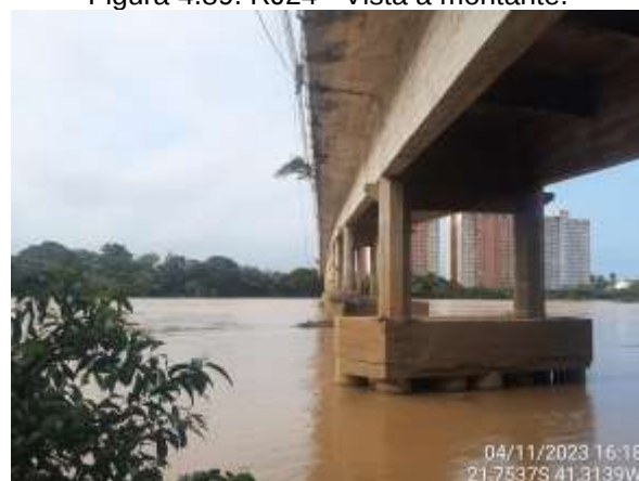
Figura 4.91. RJ24 - Estrutura da ponte
