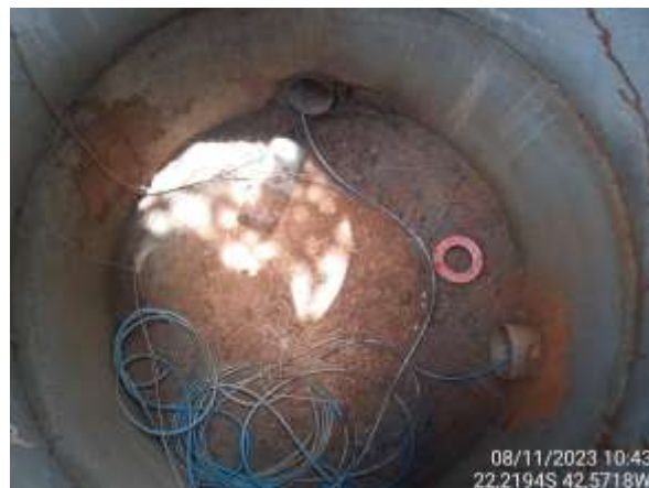
Figura 4.209. RJ15 - Condição interna.
