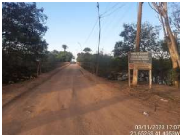
Figura 4.78. RJ23 - Acesso ao local de medição
