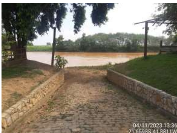
Figura 4.98. RJ25 - Acesso à seção de medição.
