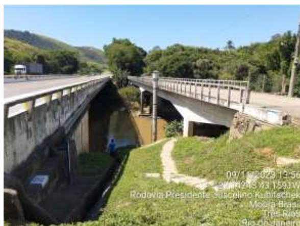
Figura 4.180. RJ11 - Local de acesso.
