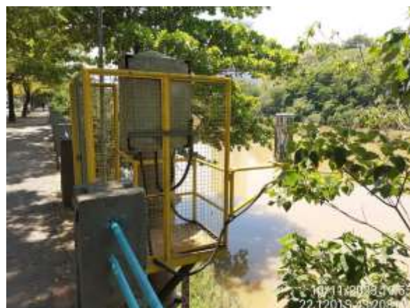
Figura 4.167. RJ09 - Vista externa estação.
