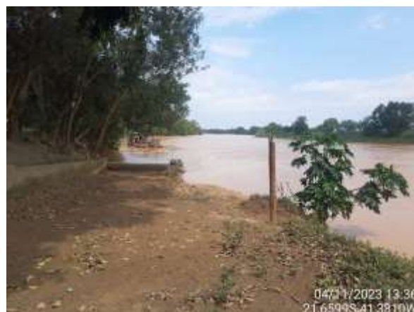
Figura 4.99. RJ25 - Vista a montante.
