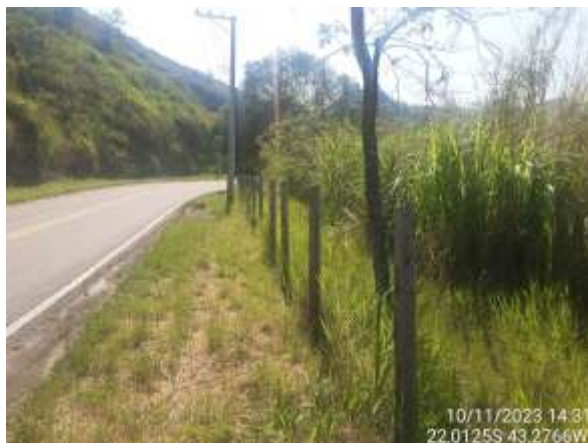
Figura 4.115. RJ30 - Cercamento dificultando o acesso ao local.
