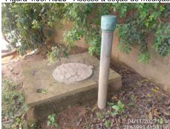
Figura 4.100. RJ25 - Estação de qualidade.
