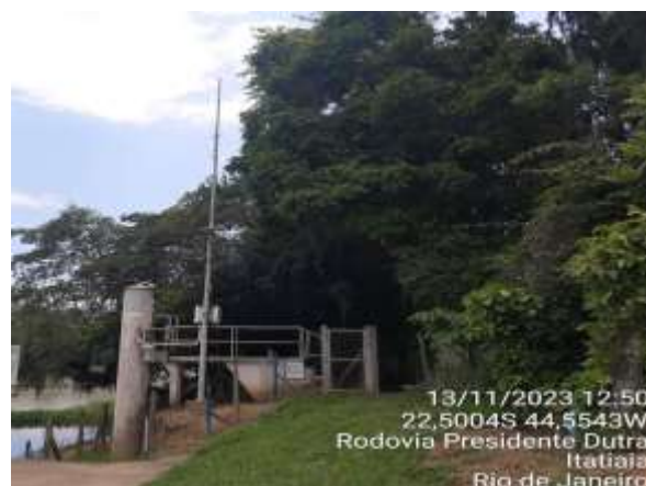
Figura 4.129. RJ02 - Vista externa da PCD.
