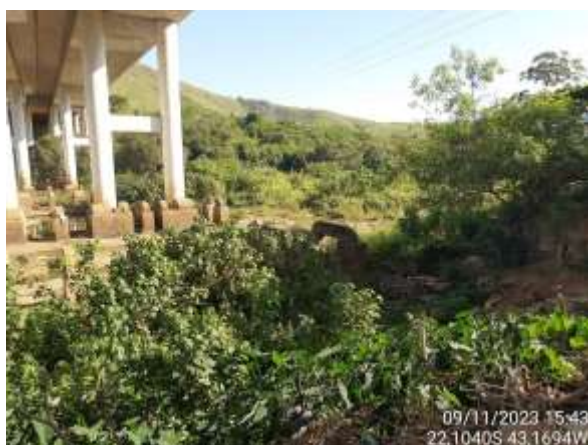
Figura 4.35. RJ10 - Local de difícil acesso.
