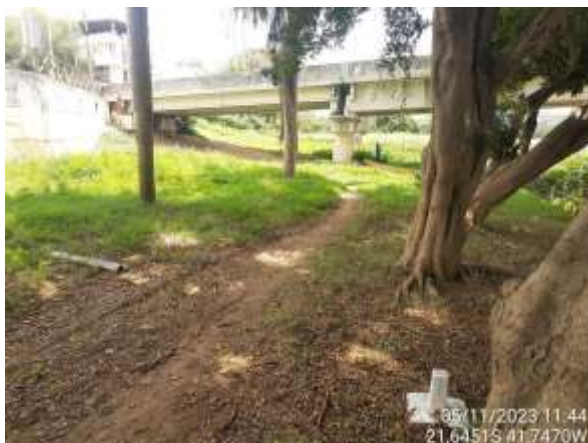
Figura 4.248. RJ21 - Local de acesso.
