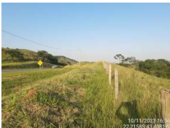
Figura 4.25. RJ08 - Cercamento dificultando o acesso.
