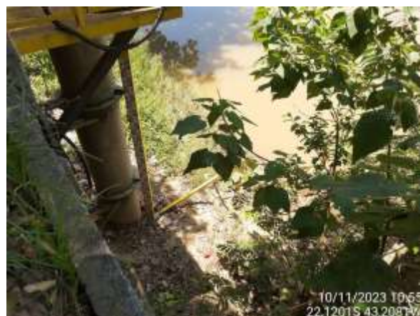
Figura 4.171. RJ09 - Régua limnimétrica.
