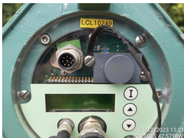
Figura 2.10. RJ15 - Vista interna da PCD.
