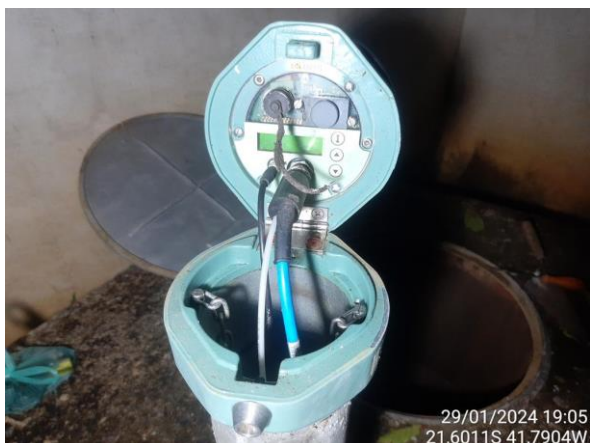
Figura 2.42. RJ20 – Vista interna da PCD.
