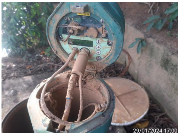
Figura 2.52. RJ25 – Vista interna da PCD.
