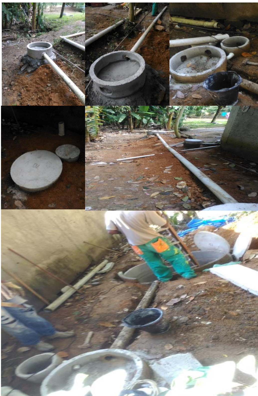
Figura 24: Instalação das caixas de gordura e da caixa de passagem e suas conexão com a segunda fossa séptica
